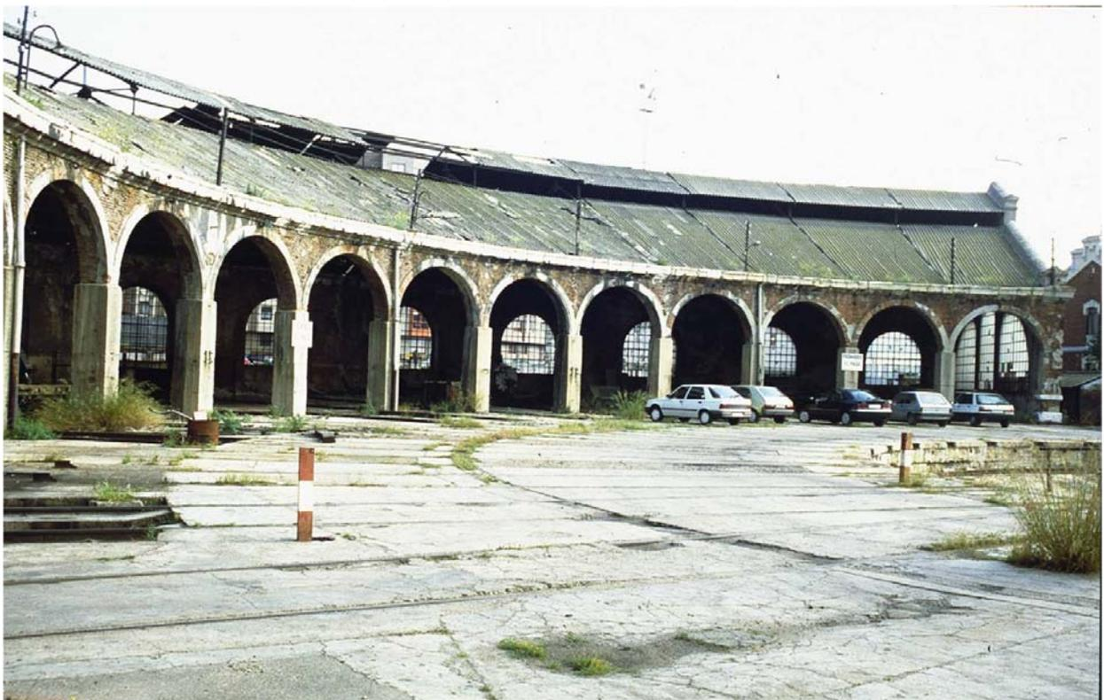
Fotografía de detalle donde se aprecia el cambio de coloración y de presencia en la cornisa de piedra y cubierta de la zona ampliada del depósito de locomotoras (4 últimos arcos de la derecha)
