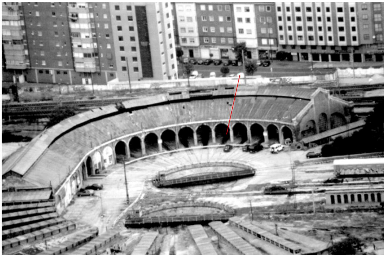
En esta fotografía antigua se aprecia la ampliación realizada en el depósito de locomotoras en los cuatro últimos arcos de la derecha. Se observa el cambio de material en la cubierta que adquiere una distinta tonalidad con el paso el tiempo y la distinta factura del lucernario.
