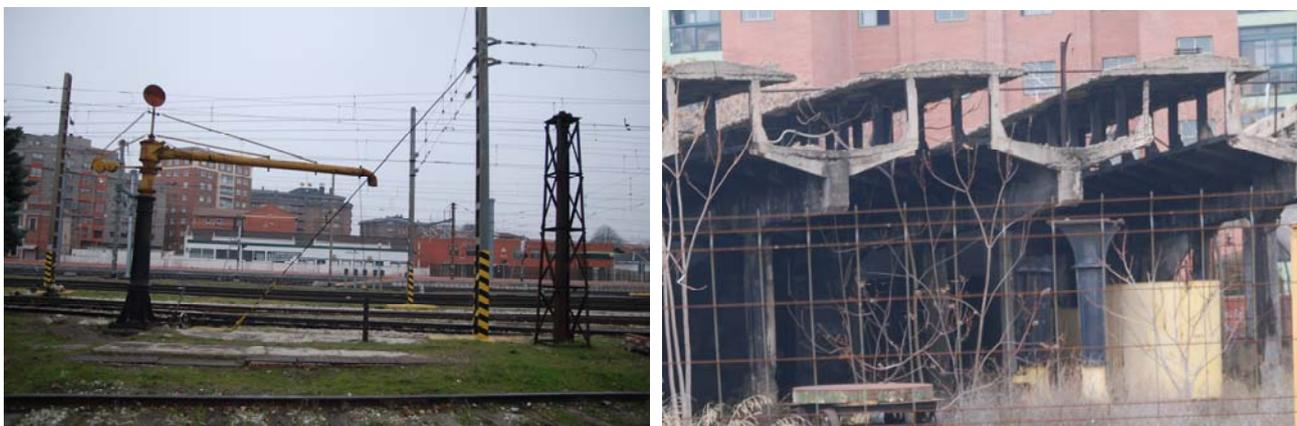
Estado actual de las Mangas de Agua o tomas hidráulicas para abastecer a las calderas de las locomotoras de vapor. En la fotografía de la derecha se aprecian también dos mangas de agua que solo conservan la base de hierro fundido. Es necesario que funcionen las que sean necesarias, como todo el depósito de locomotoras.
