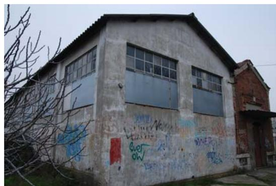
Fotografía derecha. Es el estado actual del edificio adosado a las oficinas-talleres de ferroviarios "THF", también en hormigón. Su estado de conservación es mejor puesto que se está utilizando actualmente.
