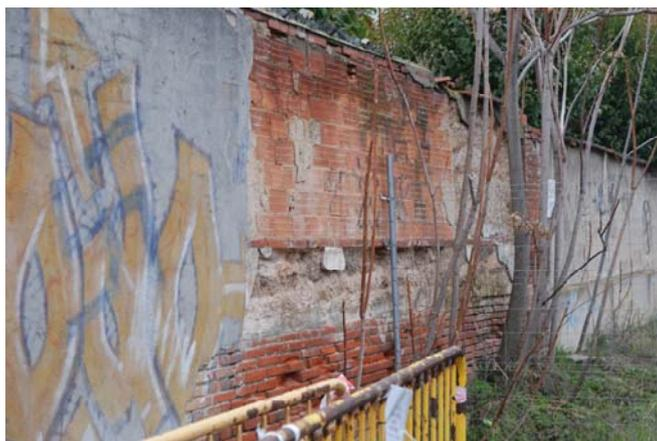
Fotografía que muestra un detalle del estado actual del muro anexo que bordea al depósito de Locomotoras por el lado Oeste. Se observa parte del tapial original. El Depósito necesita este cierre, cuya traza ha permanecido casi inalterada a lo largo de la historia. En la parte de muro preexistente deberían señalarse las fábricas más originales o significativas y en el resto se debe hacer una verja que permita la visibilidad, como era tradicional en los Talleres.
