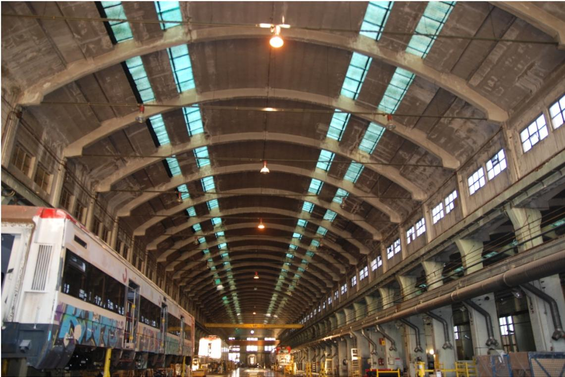
Interior de los talleres **M3**. Variante de cubierta de hormigón armado con arco de hormigón y tirante.
