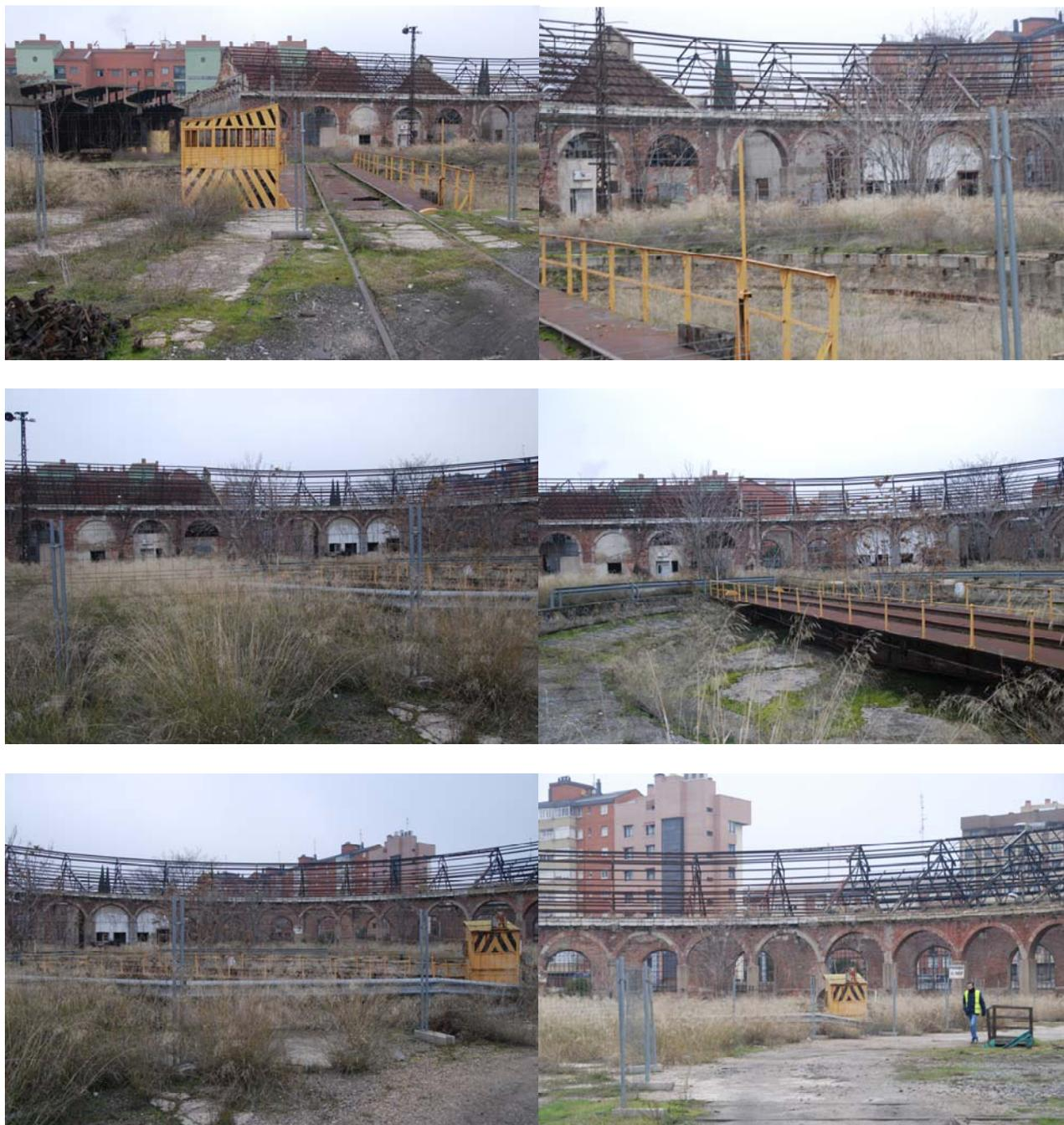
Estado actual del Depósito de locomotoras, sin cubierta y sin uso. Vista consecutiva de izquierda-derecha.
