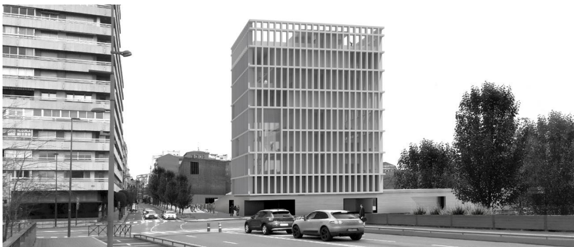
Acceso a la biblioteca desde el Paseo Isabel la Católica
