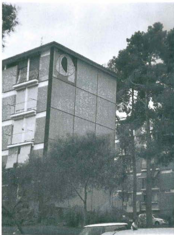
Fig. 2. Montbau: calle Poesía. Tabique pluvial con mural. Autor desconocido. Proyecto de rehabilitación del Arq. Josep Olivé Saperas. (Fuente: foto de la autora).
