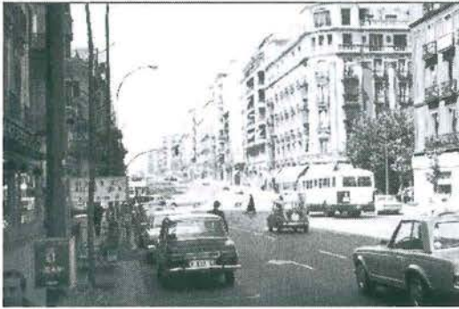
Fig. 7. Madrid. Transformación de la calle Velázquez: antes (arriba) y después (abajo). (Fuente: fotos del autor).
