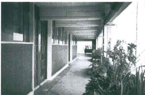
Fig. 2. Centro Urbano Presidente Alemán, Ciudad de México. Vista actual de uno de los corredores que dan acceso a los apartamentos. (Fuente: Acervo Lab. Audiovisual, Inst. Mora)
