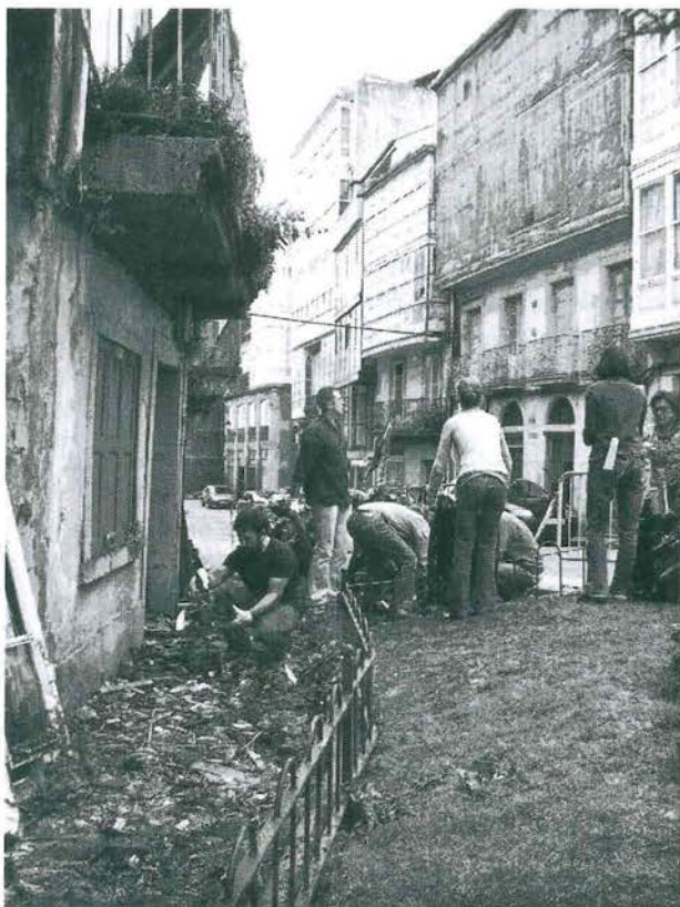
Fig. 1. Ferrol Vello: recogida de materiales desprendidos de una casa en ruinas. (Fuente: foto de los autores).
