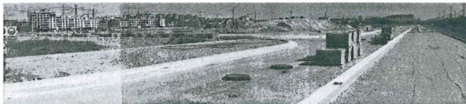
Fig. 2. Valladolid en cantera. Ciudad mineral soportada por infraestructuras ocultas.
