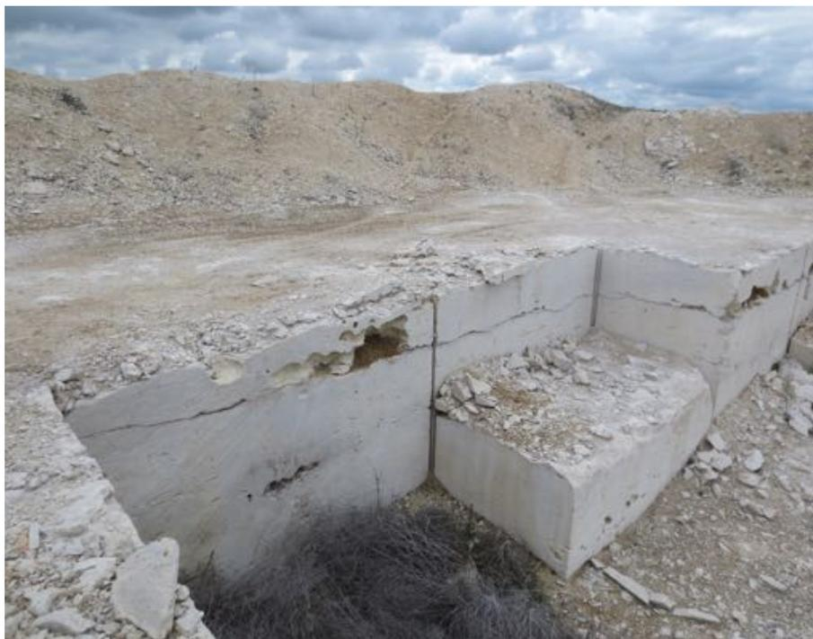
Figura 18: Frente de cantera de roca caliza.
