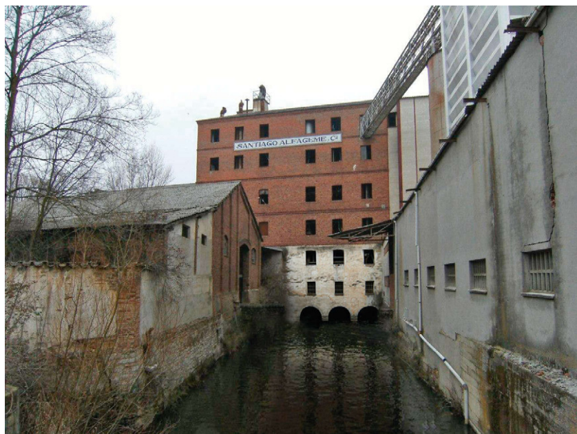
Imagen de la fábrica de harinas de Armunia (León), derribada en 2014. Tenía 6 alturas sobre la presa del Bernesga, correspondiendo los dos primeros pisos (color blanco) al primitivo molino. Foto del autor.
