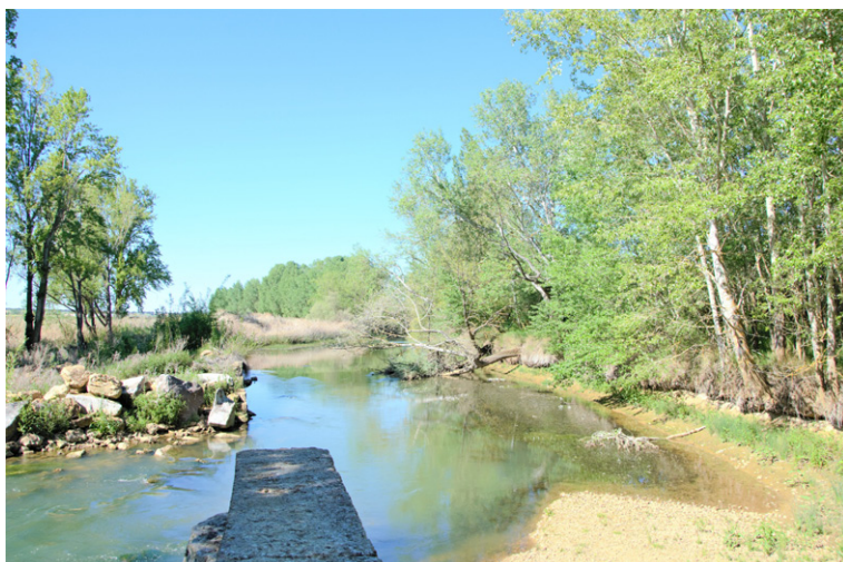
Figura 9: Cauce del río Cea superando el espacio que hasta 2017 ocupaba el azud (izquierda), dejando seco el canal de derivación (derecha). D. Herrero y E. Baraja.
