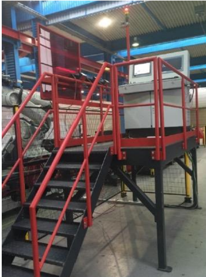
Figura 75. Estación de control.
