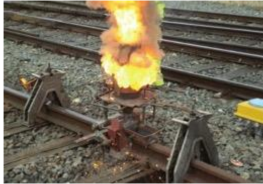
Figura 4. Soldadura vías de tren. [3]
