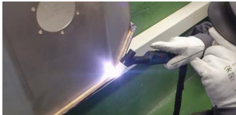
Figura 9. Soldadura por plasma. [6]
