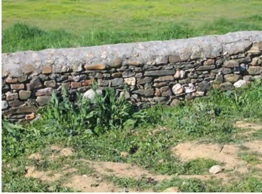
Fig. 2. Las cercas rodean la población y marcan una clara oposición paisajística con el terrazgo abierto cerealista. Construidas con rollos y pizarras, no ofrecen ningún elemento que permita datarlas con precisión, aunque todo hace pensar que el cercado de piedra debió generalizarse entre la segunda mitad del siglo XVI y el siglo XVIII. Construidas como barrera protectora contra el ganado en espacios de exclusivo aprovechamiento privado (huertas, huertos, prados, viñas), su desarrollo responde a los mecanismos de funcionamiento de los paisajes agrarios medievales y modernos.
