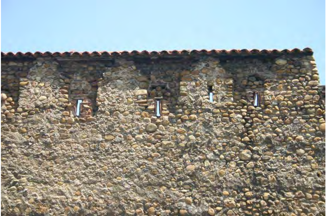
Fig. 21. Almenaje medieval tapiado para construir saeteras fusileras de ladrillo en la cerca de León. (A. Gutiérrez).
