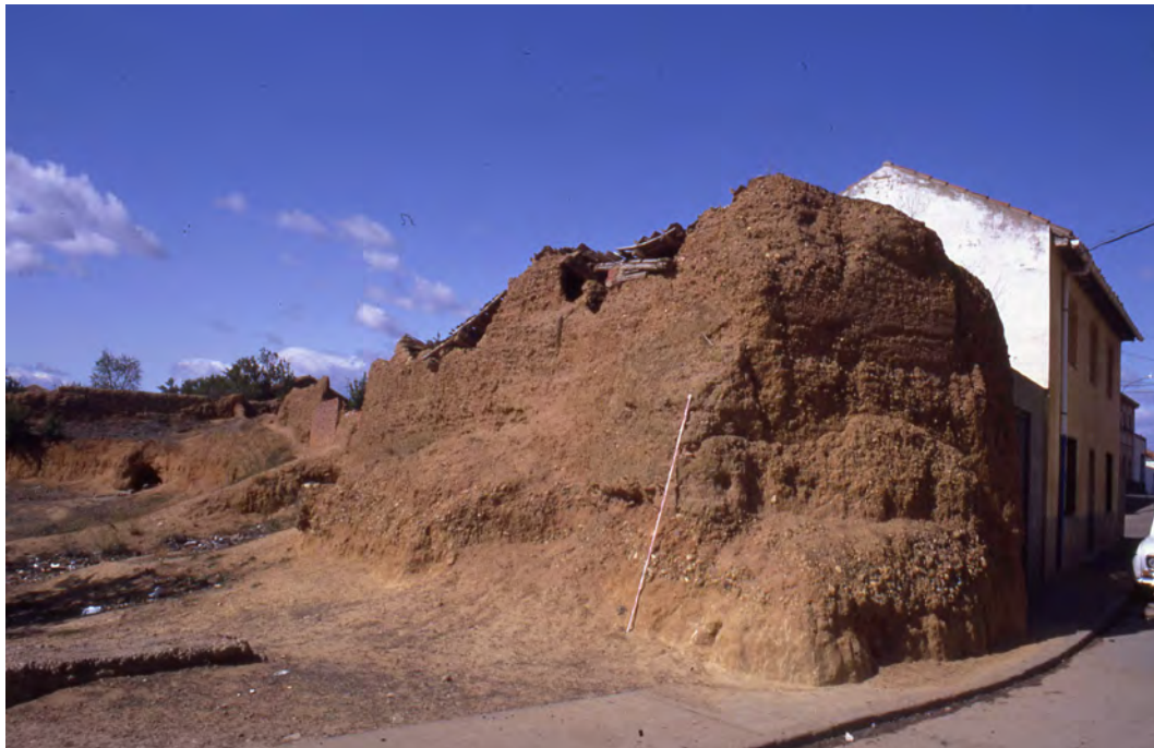
Fig. 18. Cerca de la villa de Valencia de don Juan, construida mediante tapial de barro, fotografiada en 1987 (A. Gutiérrez).
