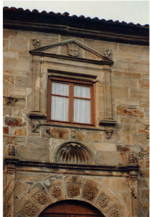
Fig. 3. Fachada de la casa Torrekoa
