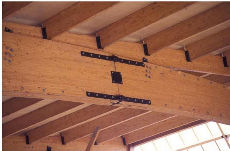
*Ilustración 2.9: Unión con placa de acero. [11]*
