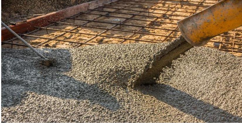
*Ilustración 4.4: Vertido de hormigón sobre armaduras. [27]*
