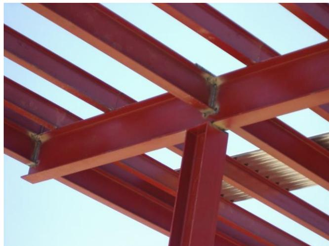
*Ilustración 2.8: Unión soldada. [9]*
