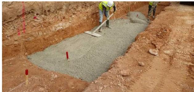
*Ilustración 4.3: Vertido hormigón de limpieza. [26]*
