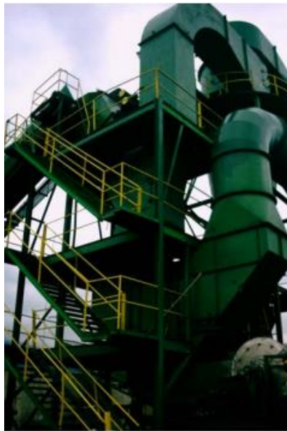
Figura 15. Conductos de aspiración de residuo ligero. [Recuperado de: Ecolec Proceso de Reciclaje]
