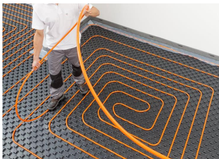
Figura 2.16. Disposición del suelo radiante en forma de espiral.
