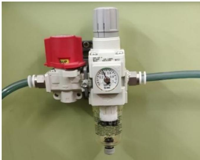
Figura 52. Toma de aire comprimido de la EII
