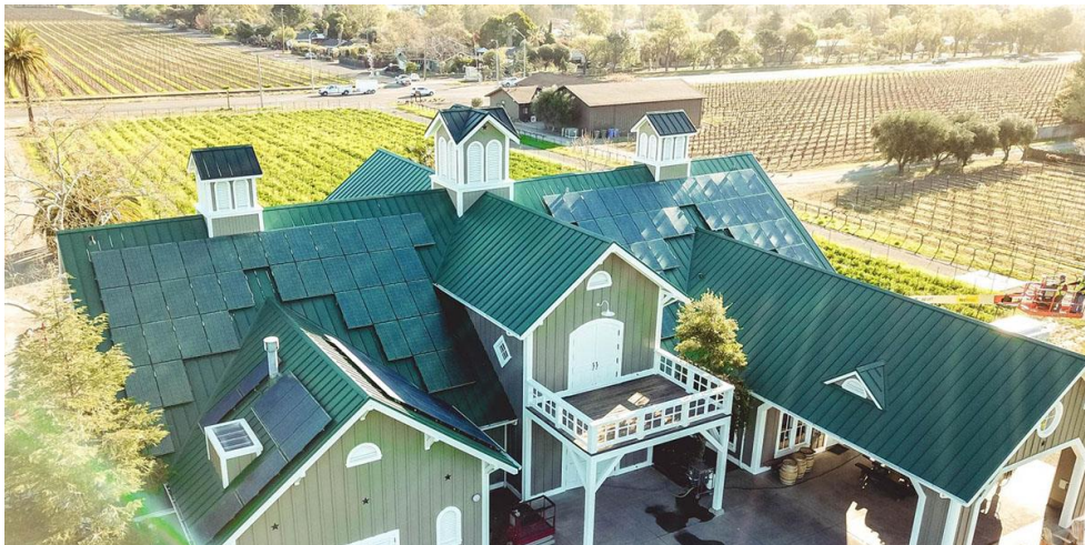
Ilustración 25: Techo fotovoltaico - Bodega en California
