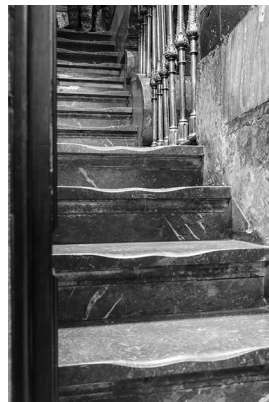
53 Escalera acceso Apóstol Santiago
