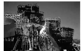
17 Fase de construcción Guggenheim
