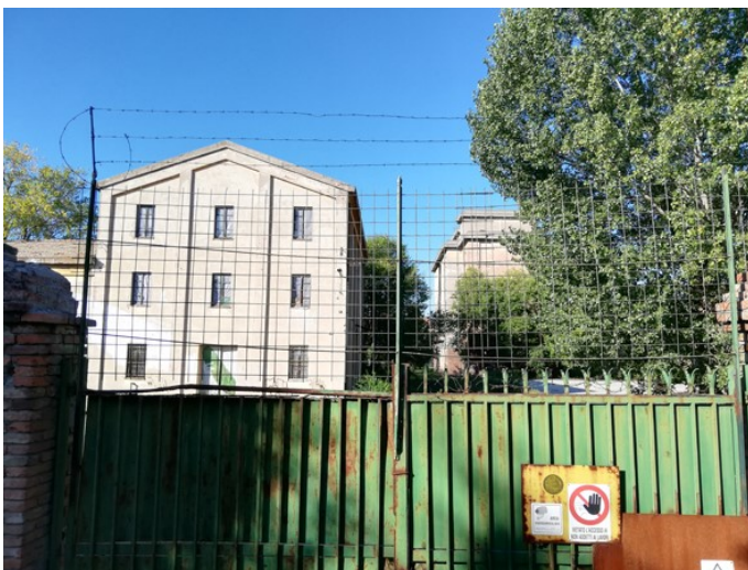
Figura 17. Edificios del cuartel Sani absortos en la vegetación. Fuente: F. Camerin (2019)
