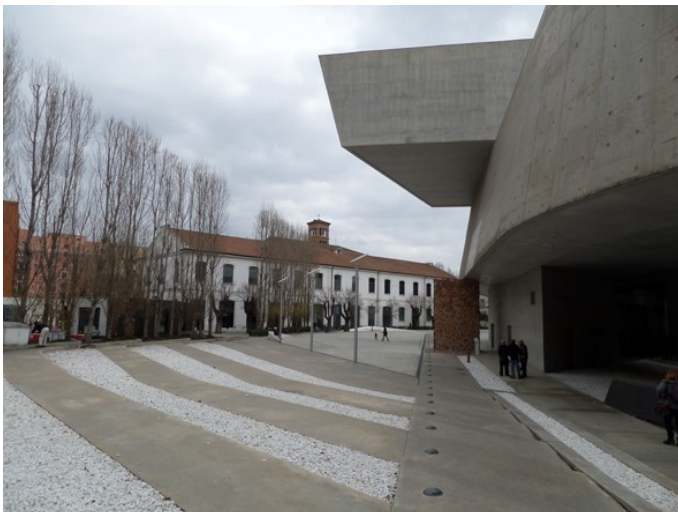
Figura 25. Vista del edificio restaurado del cuartel Montello, hoy funcional al museo MAXII. Fuente: F. Camerin (2017)
