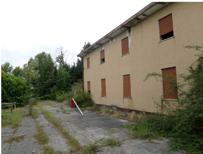
Figura 29. Espacios degradados del cuartel Zanusso. Fuente: F. Camerin (2015)
