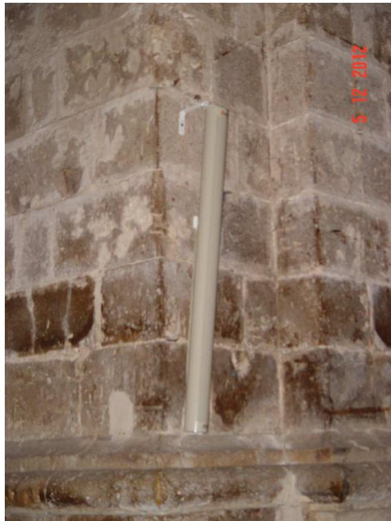
Fig. 7.3.38. Detalle de instalación de megafonía.
