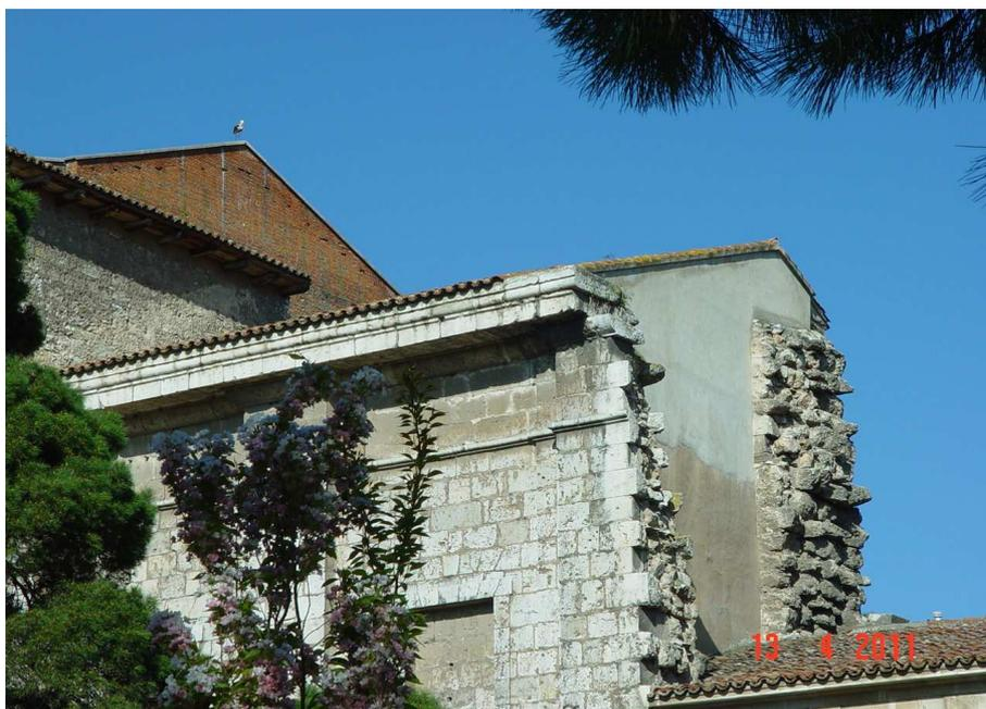
Fig. 7.3.9 Vista exterior, detalle del estado actual de los cerramientos, a Plaza de la Universidad.
