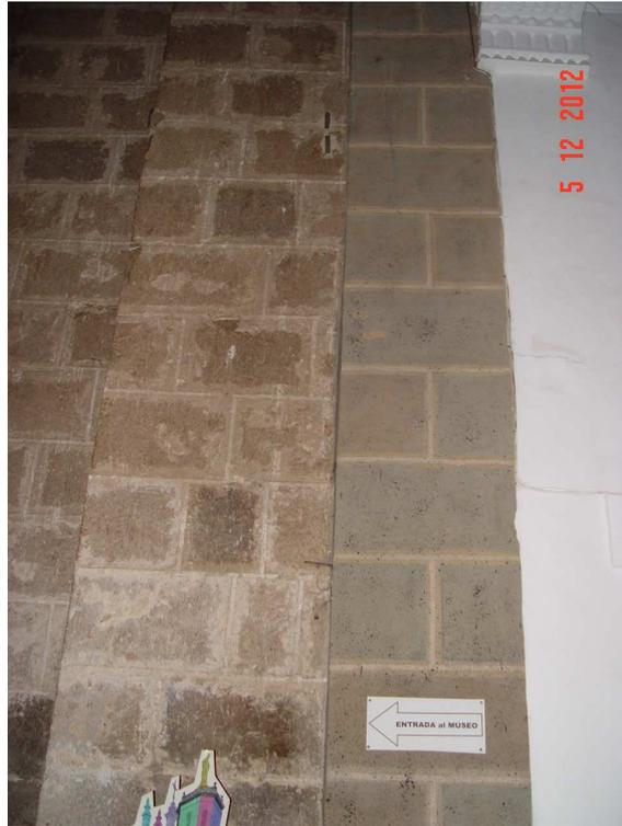
Fig. 7.3.39. Detalle de encuentro de sillería de caliza con enfoscado de mortero cemento.
