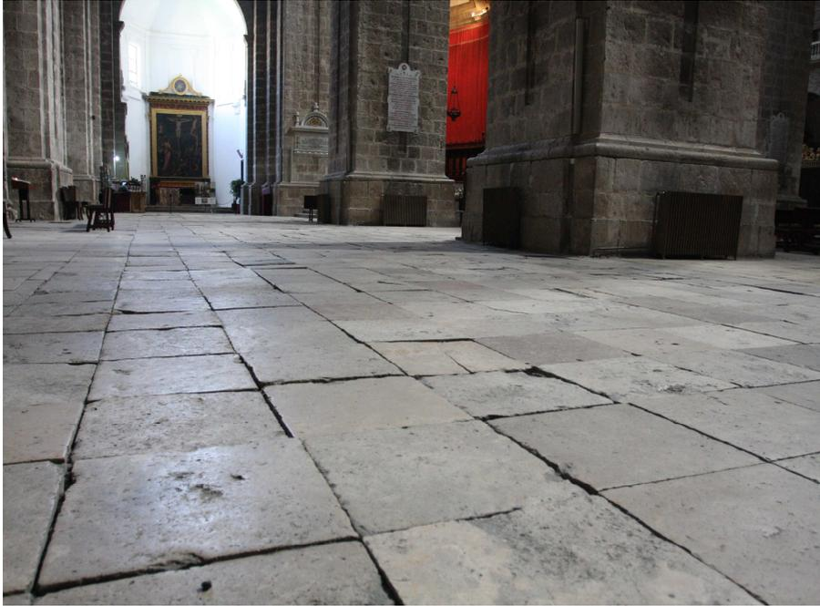
Fig. 7.3.35. Detalle del pavimento de piedra caliza, nave del evangelio.
