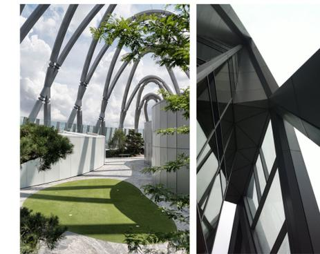
La estructura exterior permite una fachada doble piel que permite una ventilación pasiva para menos solicitar el sistema de aire acondicionado. Además, la torre utiliza varias tecnologías para bajar su consumo de energía.
