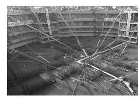
Como la capa resistente de roca se encuentra demasiado profunda, la cimentación de todos estos rascacielos se produce por pilotes trabajando por fuste. Estos no funcionan apoyándose, si no que funcionan por rozamiento y debido a la compactación de la tierra que se crea al introducirlos. Los pilotes de las torres de Shanghai llegan hasta los 55m de profundidad los más grandes.
