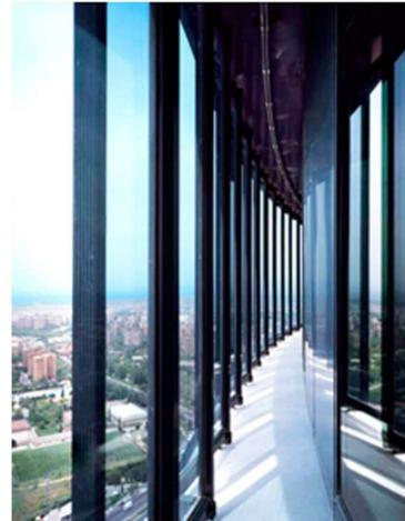
Imagen 23. Detalle de la pasarela de mantenimiento.
