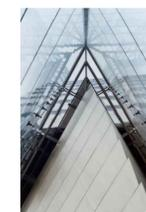
Las fachadas de vidrio son ventiladas, doble acristalamiento en determinadas caras de las torres. La subestructura de las carpinterías exteriores de las caras inclinadas de vidrio se apoyan en los forjados.
