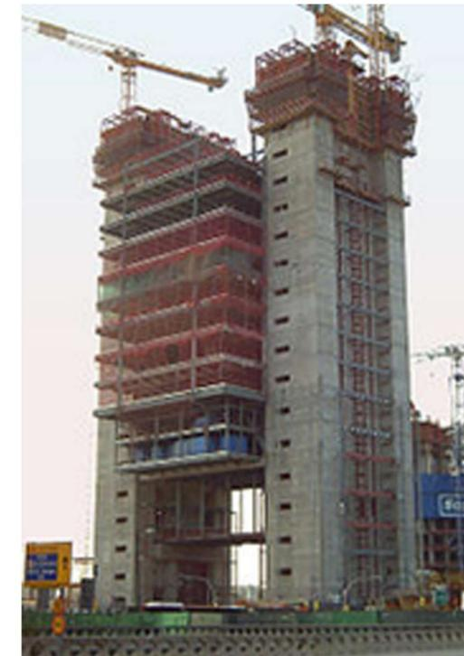
Imagen 14. Construcción de los núcleos y forjados.
