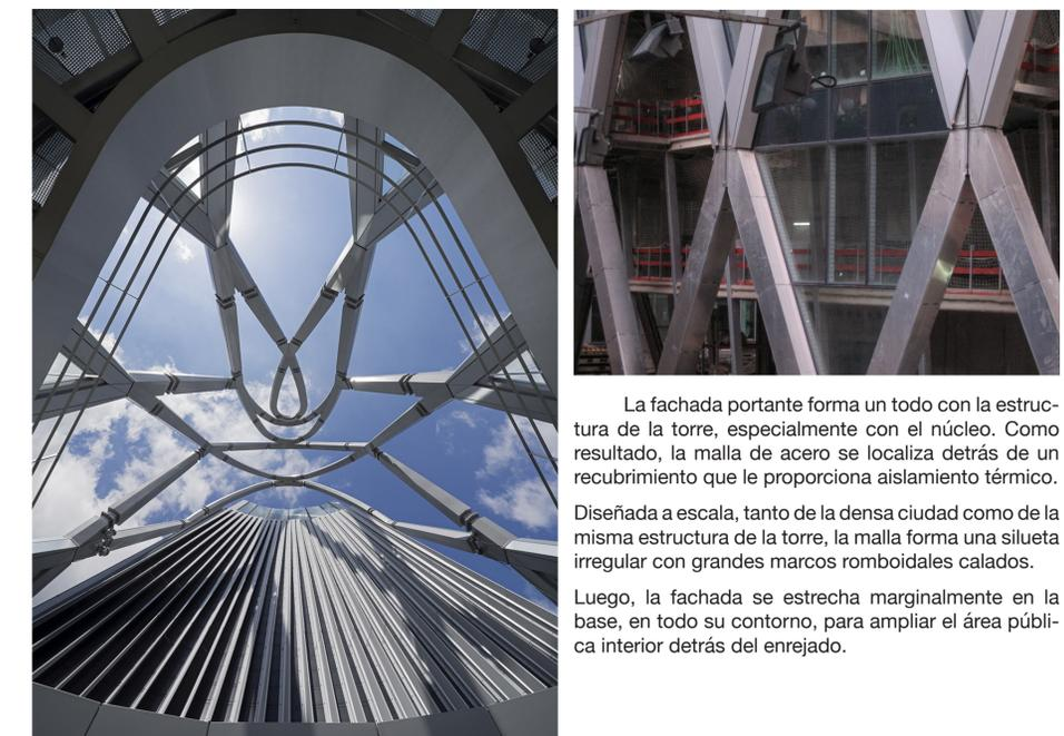
La fachada portante forma un todo con la estructura de la torre, especialmente con el núcleo. Como resultado, la malla de acero se localiza detrás de un recubrimiento que le proporciona aislamiento térmico.
