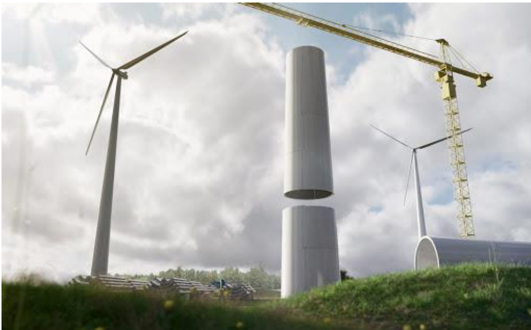
Ilustración 13.- Construcción de una torre de acero
