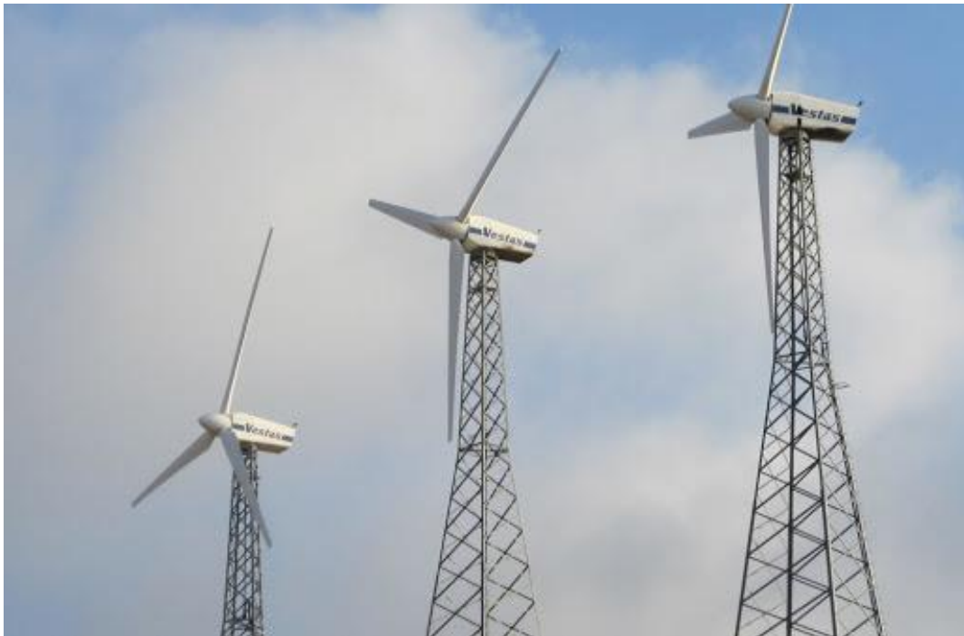
Ilustración 14.- Torre de acero en celosía
