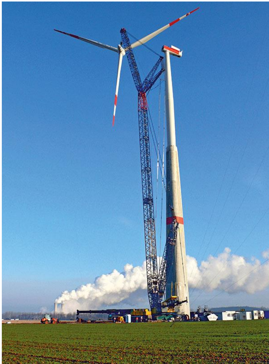
Ilustración 16.- Torre híbrida hormigón-acero
