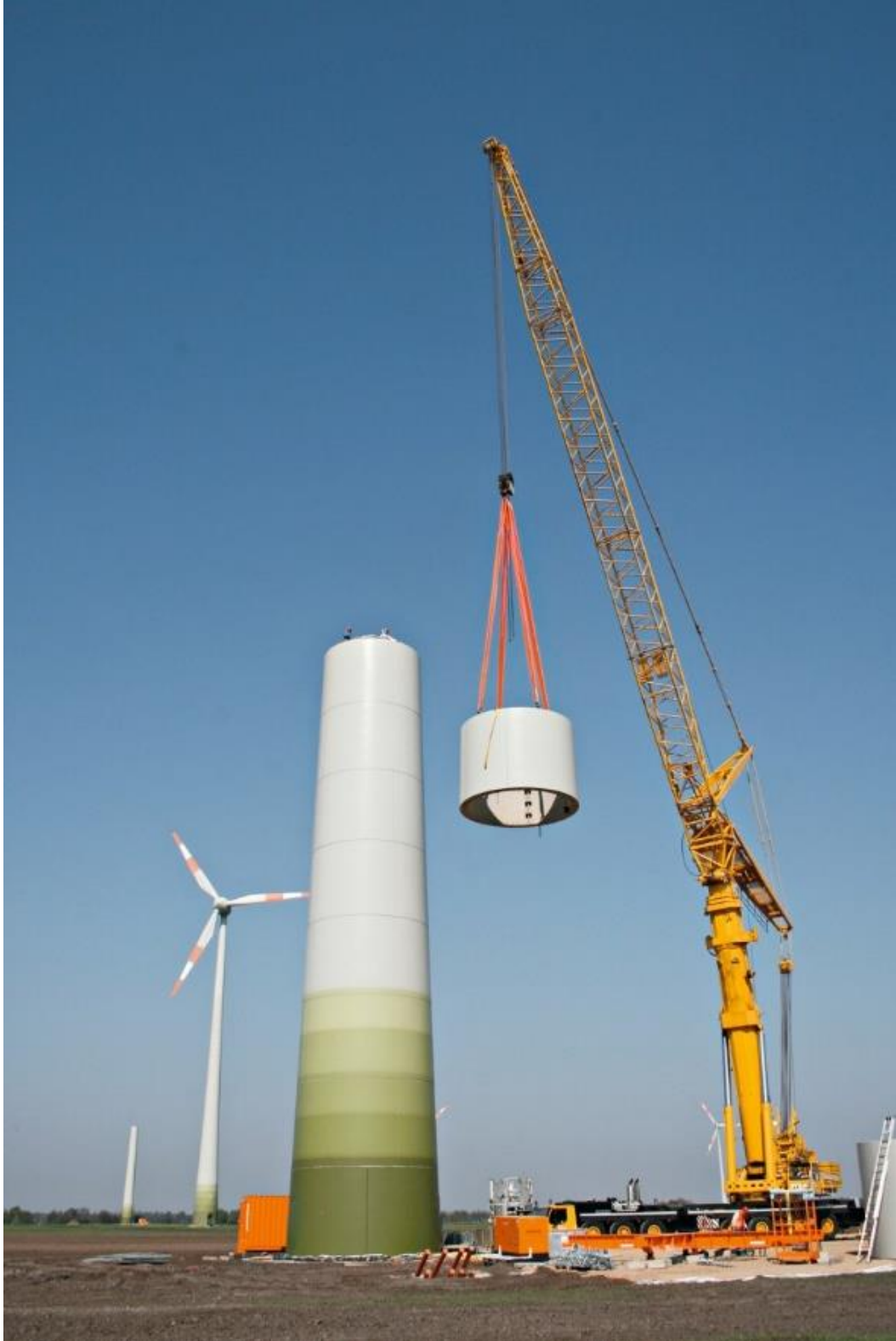
Ilustración 12.- Construcción de una torre de hormigón prefabricado
