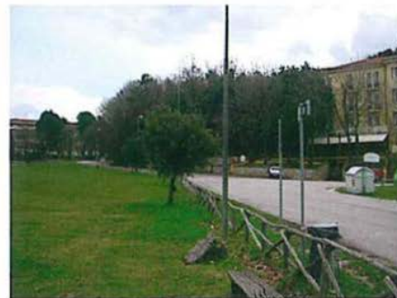
Scarsa utilizzazione dei complessi edilizi esistenti cesura viaria degli spazi verdi e discontinuità dei percorsi pedonali
