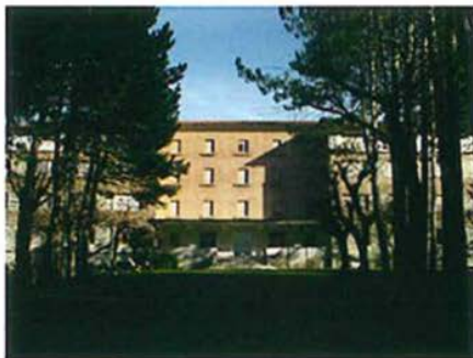
Scarsa utilizzazione dei complessi edilizi esistenti (INPDAP)
