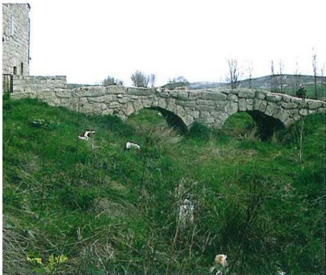
Puente en Hornillos del Camino
