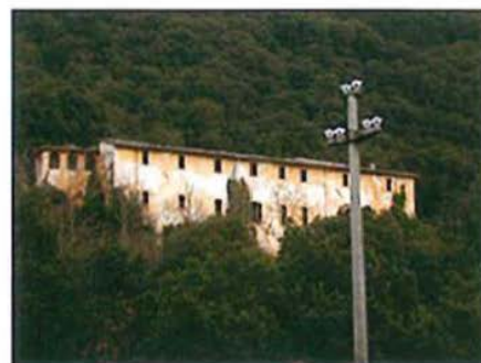
Complessi architettonici in abbandono (ex convento di S. Antonio/Fortilizio dei Mulini)
