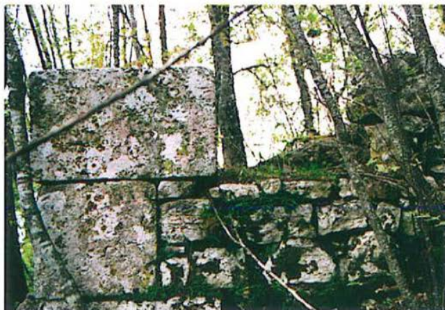
Scheggino, loc. Case San Silvestro. Strutture romane pertinenti verosimilmente al podio di un tempio.
