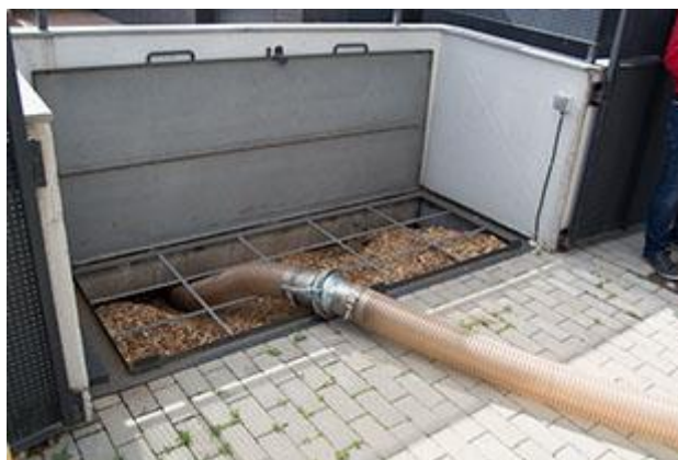
Ilustración 16 Descarga neumática de astilla
