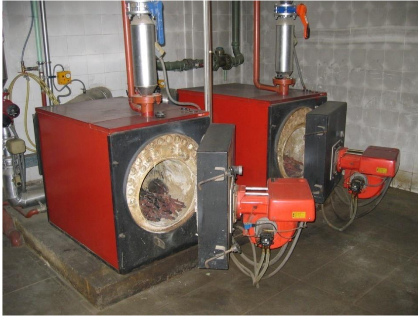
Figura IV. 8. Calderas de gasóleo
