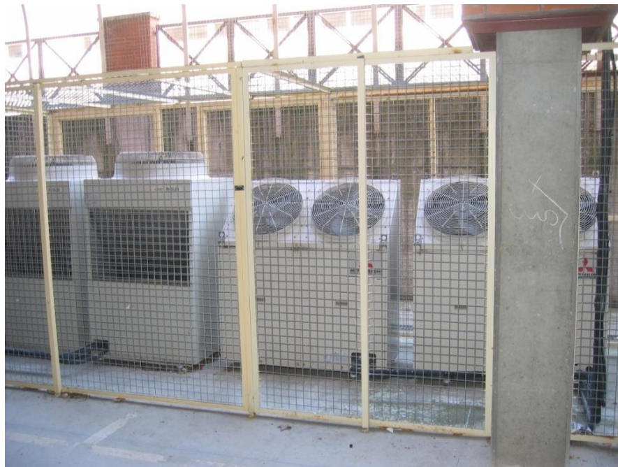
Figura IV. 10. Unidades exteriores de refrigeración
