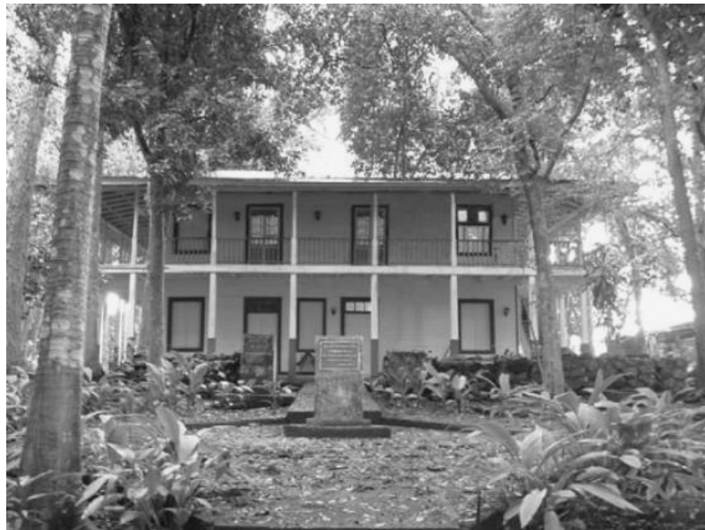
Figura N°13. Casona Hacienda El Coyolar Fuente: http://www.patrimonio.go.cr/busqueda/Inmueble.aspx
