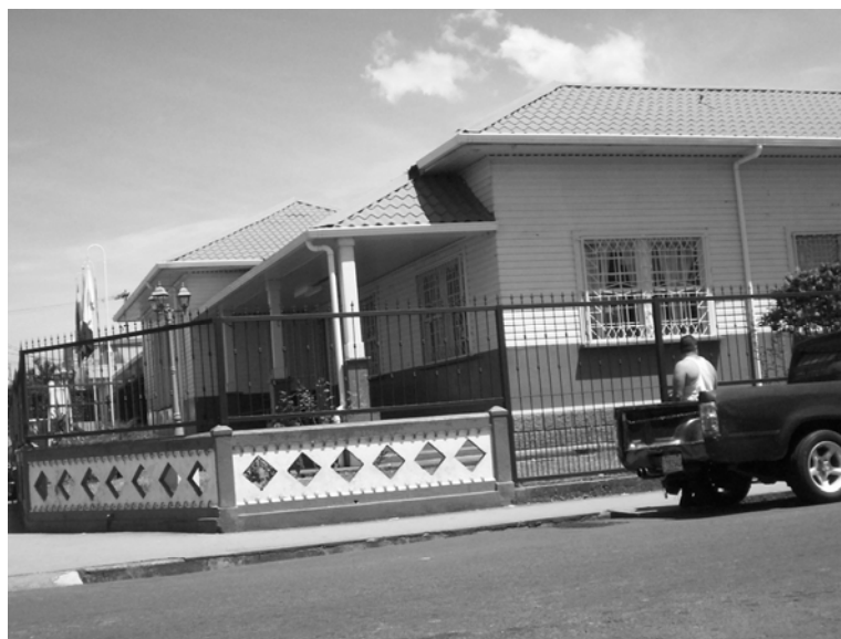
Figura N°10. Palacio Municipal de Naranjo
