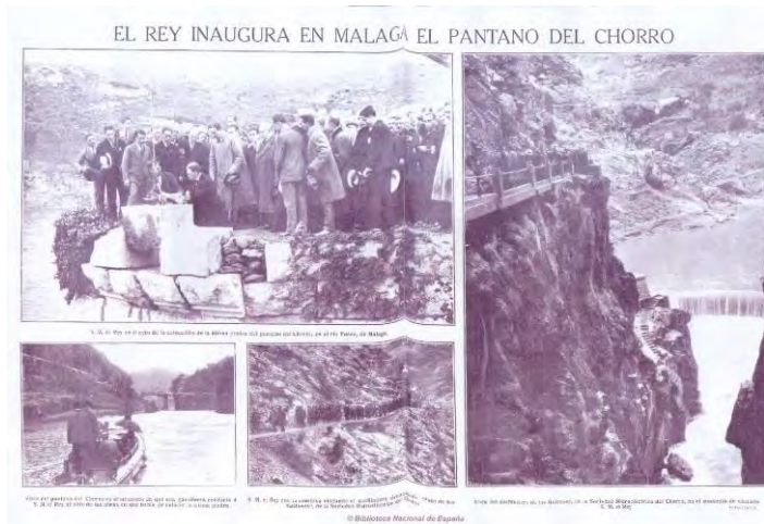
Figura 9. El mundo Gráfico . Imágenes de la visita del rey Alfonso XII al Chorro para inaugurar las obras de ingeniería de la zona en 1921.
