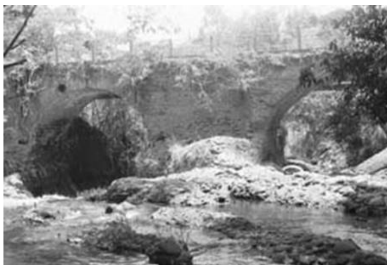
Figura N° 18. Puente de Piedra, Piedades Sur, San Ramón
