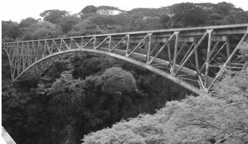
Figura N° 20. Puente ferroviario sobre el río Grande, Atenas
