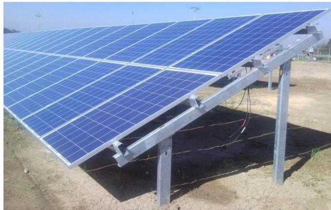
Ilustración 5. Estructura solar fija.
