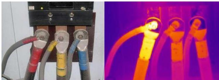
Ilustración 34. Imagen termográfica conexión en mal estado
