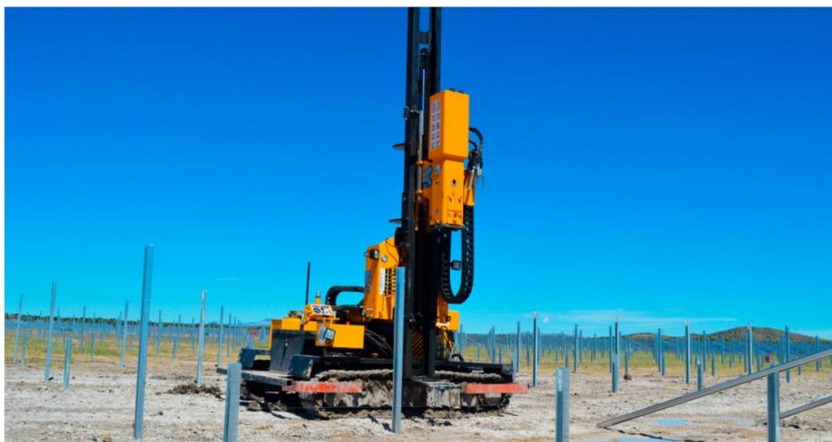
Ilustración 15. Máquina hincadora.
