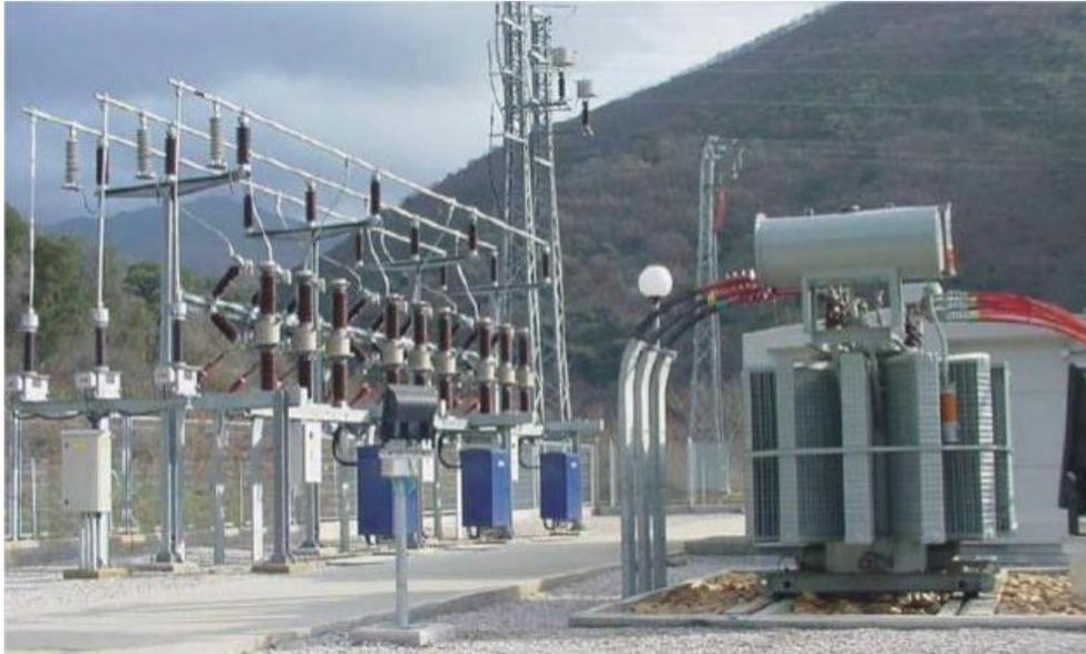
*Ilustración 20. Centro de transformación de intemperie.*
