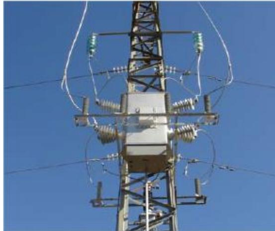
Ilustración 27. Interruptor – Seccionador en SF6 (OCR)
