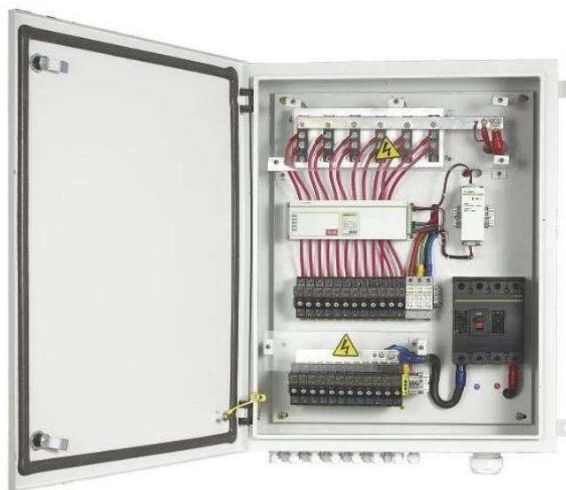
Ilustración 9. Interior de caja de conexiones
