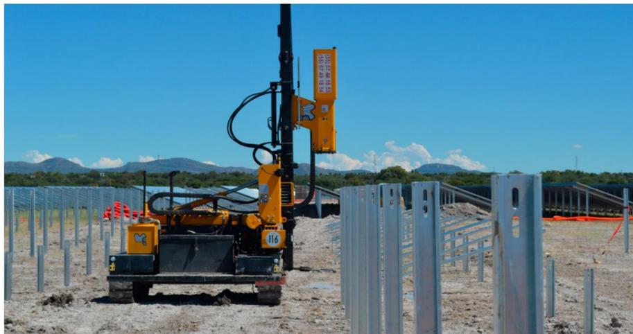
Ilustración 14. Máquina hincadora.
