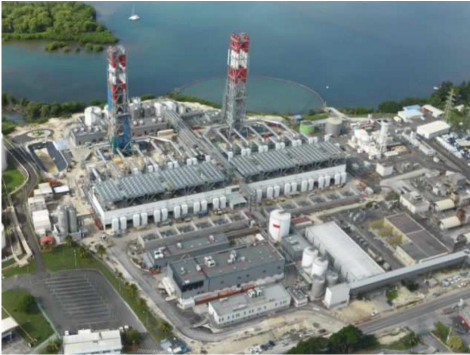
Figura 30. Vista general de la planta.
