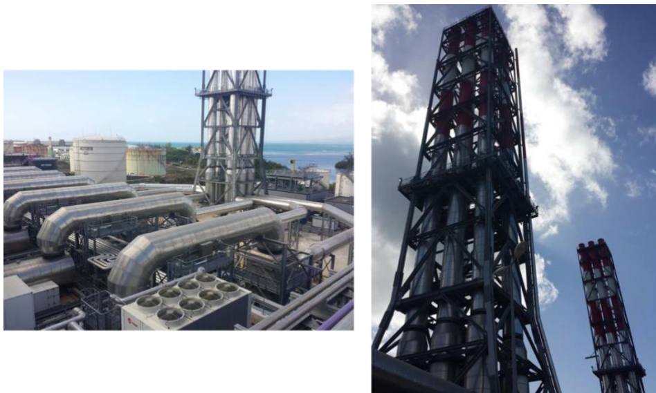
Figura 38. Vista del Sistema de Chimeneas 2.
