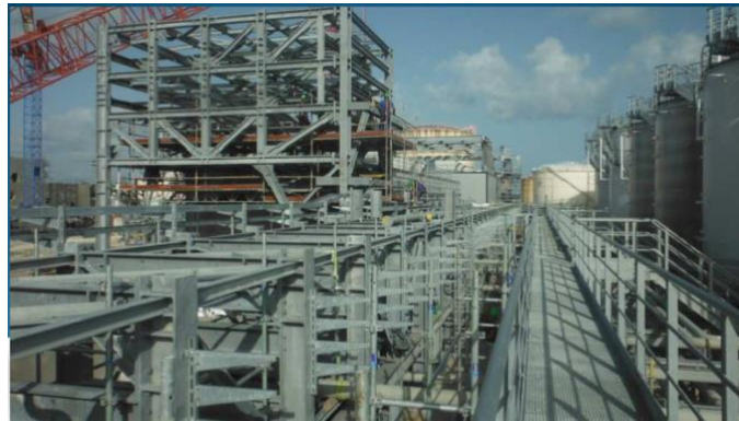
Figura 21. Vista Estructura de acero 1.
