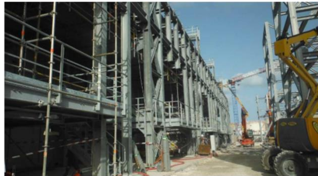
Figura 22. Vista Estructura de acero 2.
