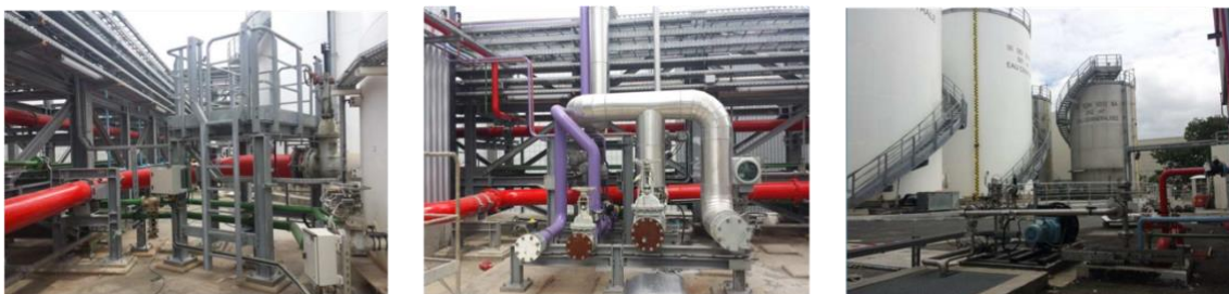
Figura 39. Vista de la zona de Tanques.
