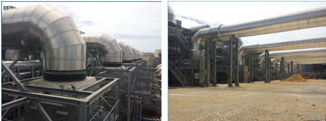
Figura 37. Vista del Sistema de Chimeneas 1.
