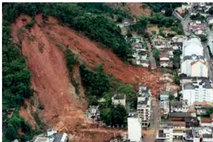
Fig 2. Deslizamiento de tierras.
