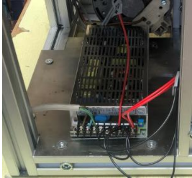
Figura 79: Fuente de alimentación. (Elaboración propia)
