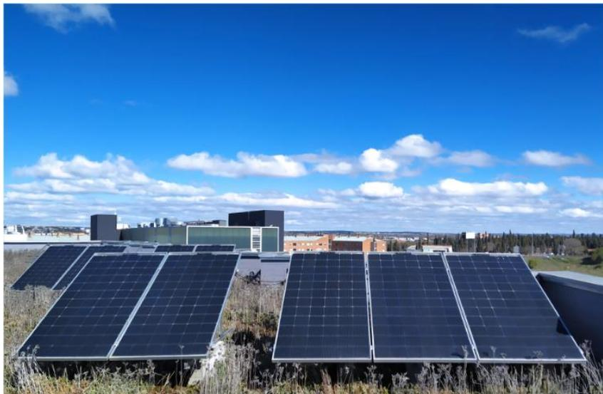
*Figura 4. Instalación Fotovoltaica de paneles bifaciales en la azotea del edificio LUCIA.
