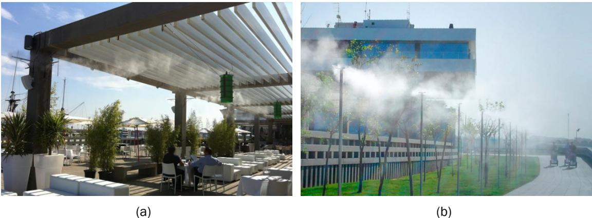
*Figura 12 - Sistemas de micropulverización de agua de la línea Mist&Fog de la empresa Termigo [17].*
