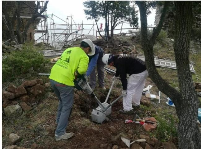
*Ilustración 27: Instalación de Piloedre. Piloedre.es*
