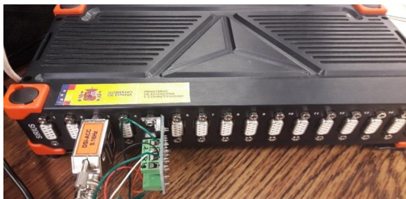
Figura 16. Conexión del acelerómetro (a la izquierda, en el canal 3) y célula de carga (a la derecha, en el canal 5), al equipo SIRIUS HD-STG.
