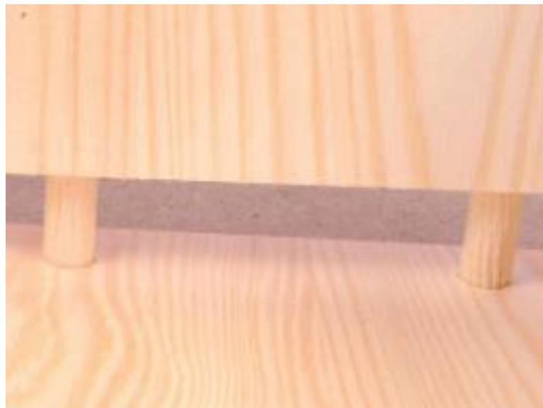
Ilustración 14| Ensamble con tubillones | https://www.hogarmania.com/bricolaje/taller/tecnicas/como-ensamblar-maderas-tubillones-23171.html
