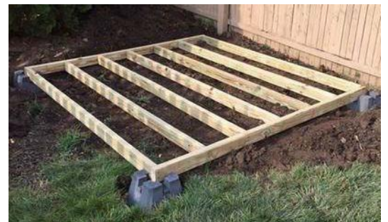
Ilustración 79| Entramado de maderas. | https://hortum.es/blog/base-para-casetas-de-jardin-suelos-para-casetas-de-madera-n10/
