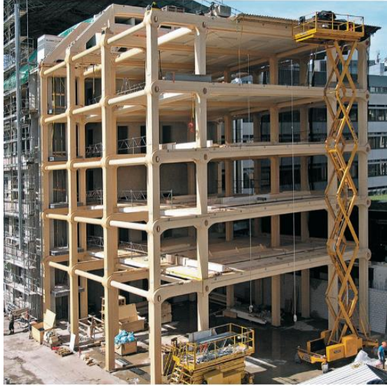
Ilustración 10| Detalle de la estructura del edificio | https://www.plataformaarquitectura.cl/cl/02-341234/en-detalle-sistema-de-ensambles-oficinas-tamedia-shigeru-ban-architects
