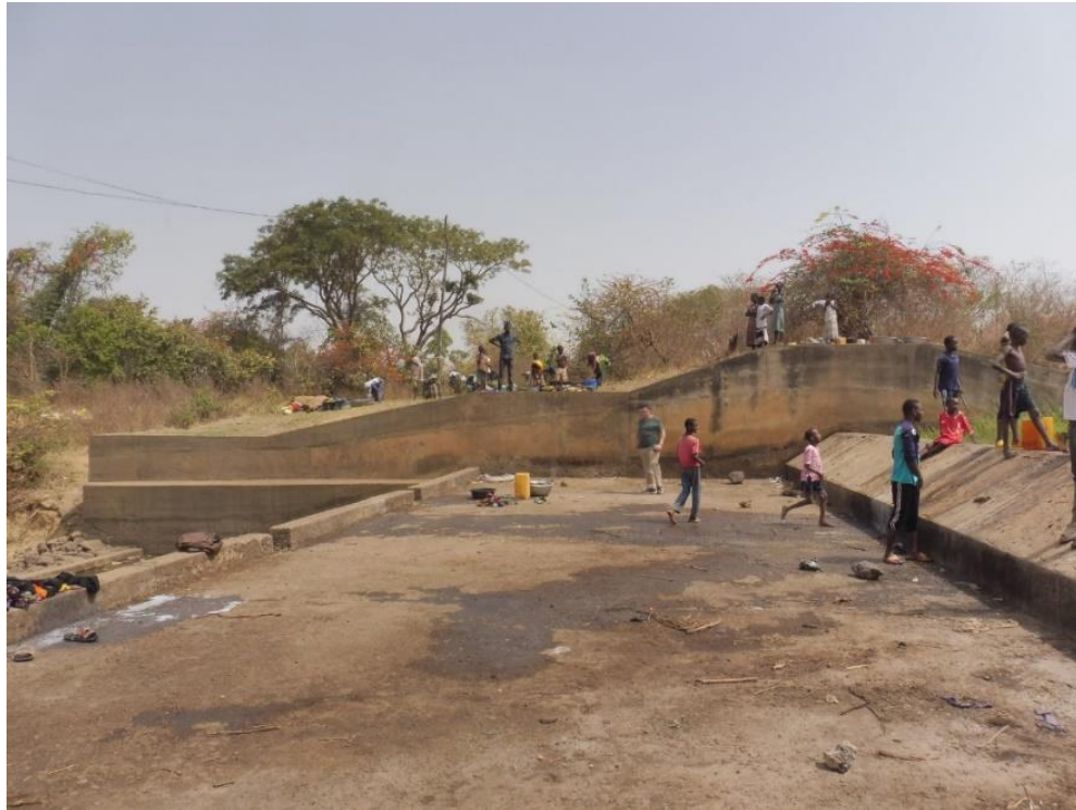
Figura 54: Fotografía del tramo horizontal del azud.
