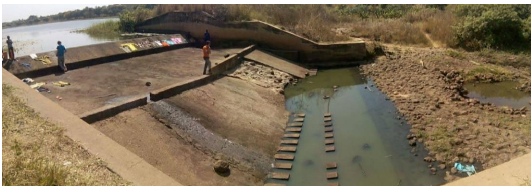
Figura 31: Fotografía 3 del azud de Nikki sin caudal.
