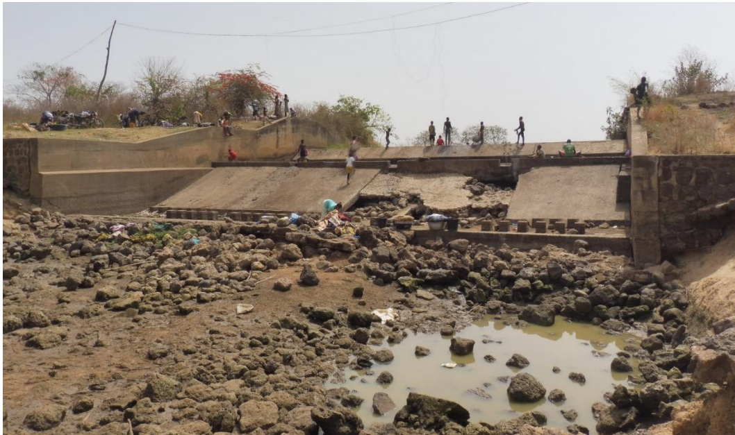
Figura 49: Fotografía del aliviadero del azud
