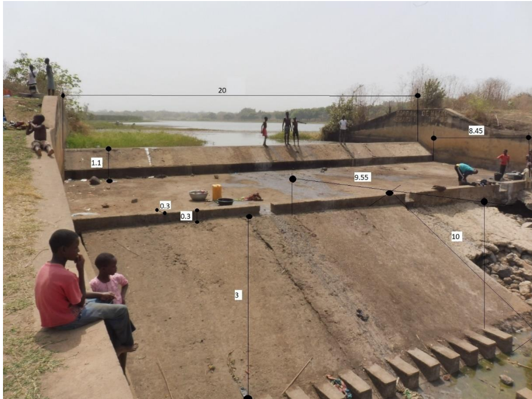
Figura 51: Esquema de medidas en metros del azud de Nikki.
