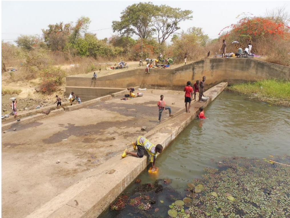
Figura 50: Fotografía del murete del aliviadero que se necesitaría demoler parcialmente.
