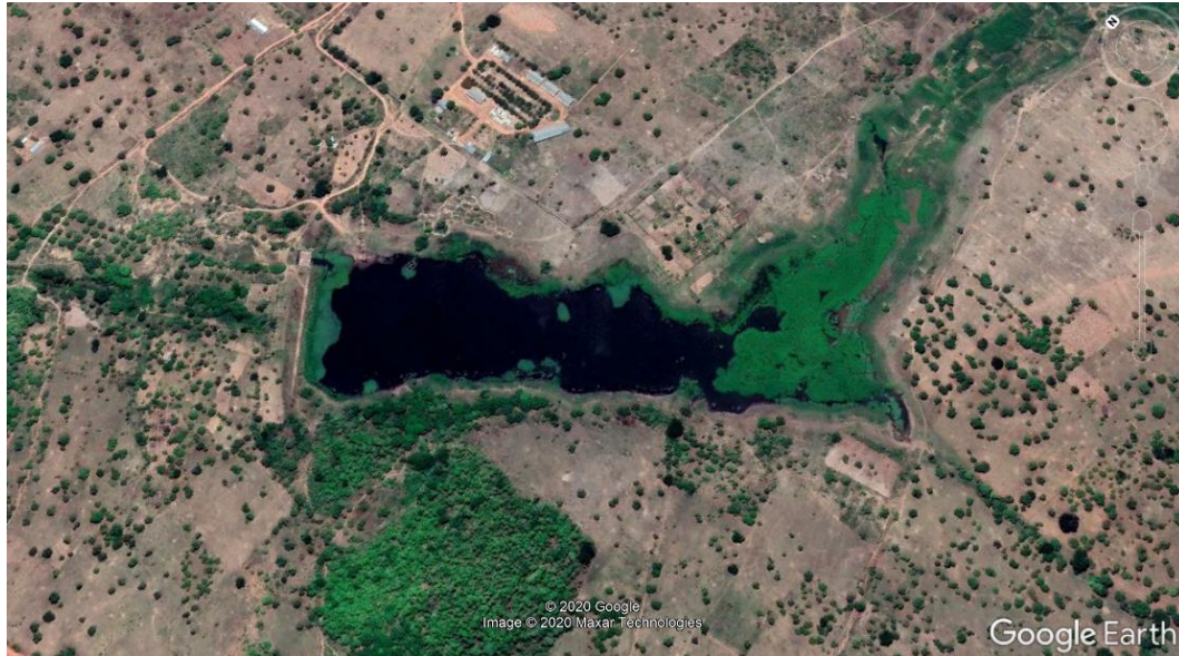
Figura 16: Vista de la presa de Nikki (Google Earth).
