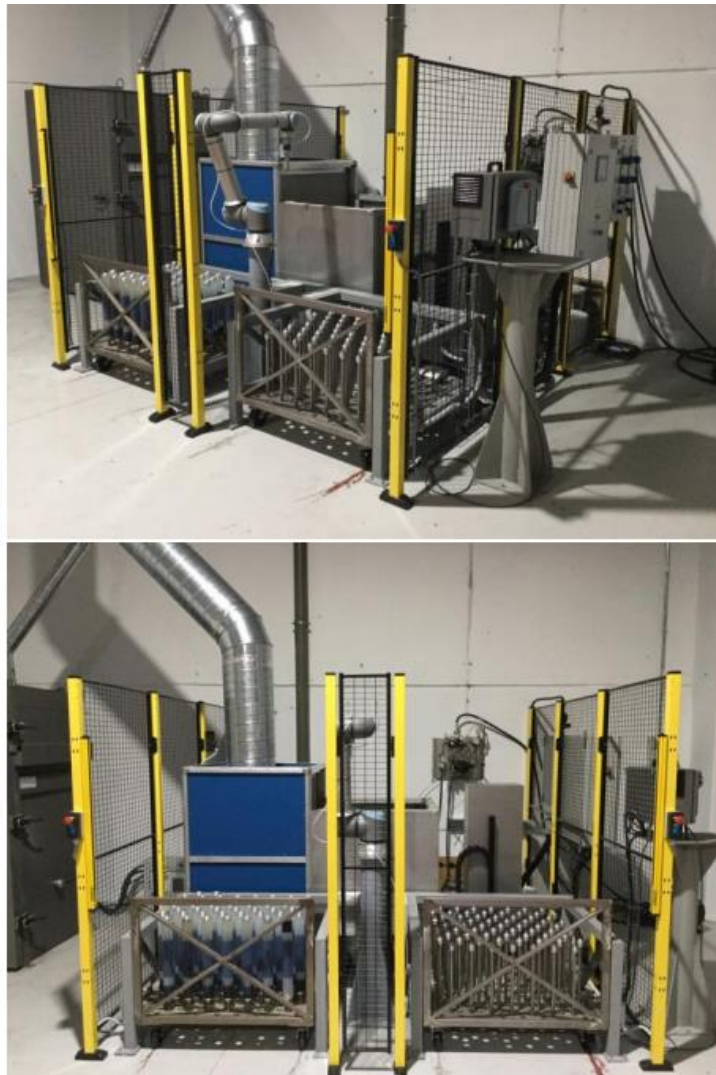
Figura 6. Instalación de la estación de pintura.
