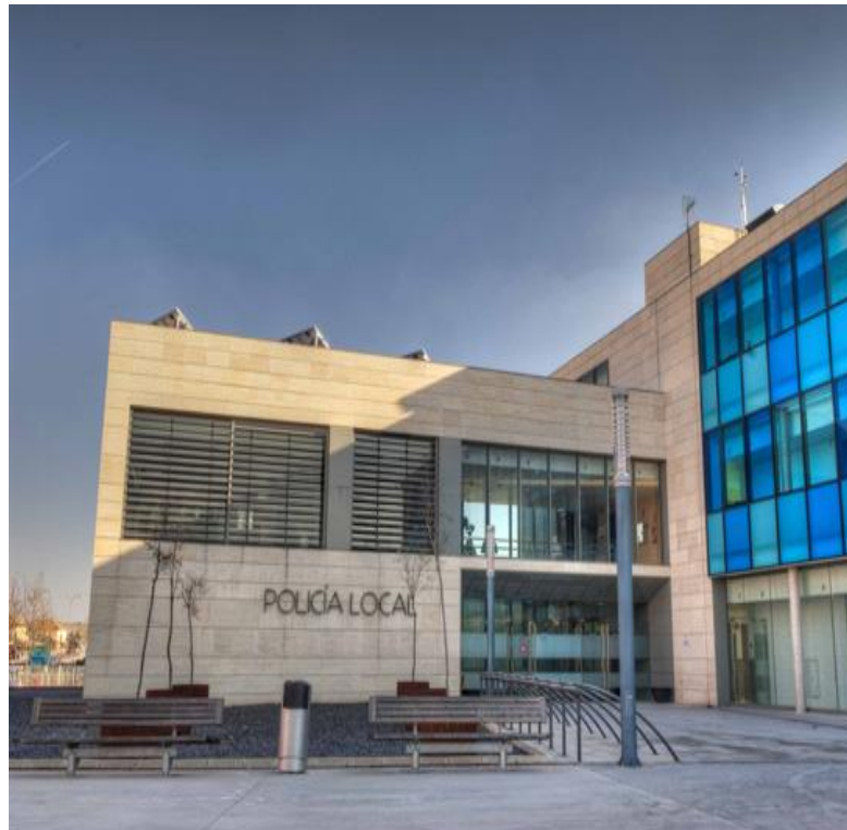
Edificio de la Policía Local de Rivas-Vaciamadrid
