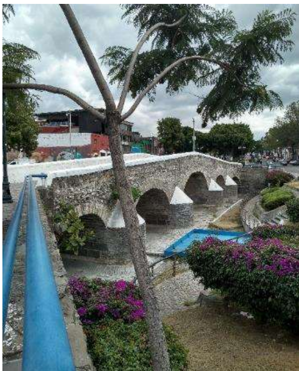
Figura 33. Puente de Ovando, fotografía propia tomada en octubre de 2019
