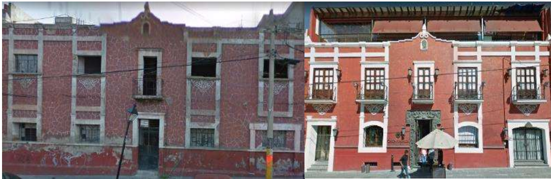
Figura 8. Cambio de uso de suelo a comercial, avenida 3 oriente esquina con 12 sur, barrio de Analco.
