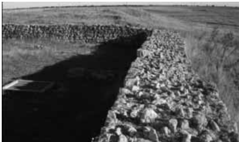
Muro del castillo de Fuenteungrillo [2008]
