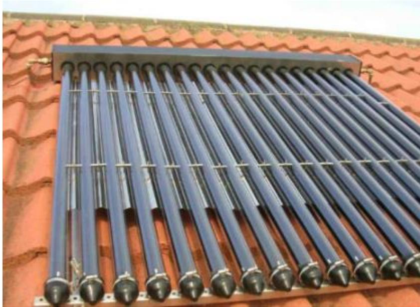
*Figura 41: Colector solar de tubos de vacío.*
