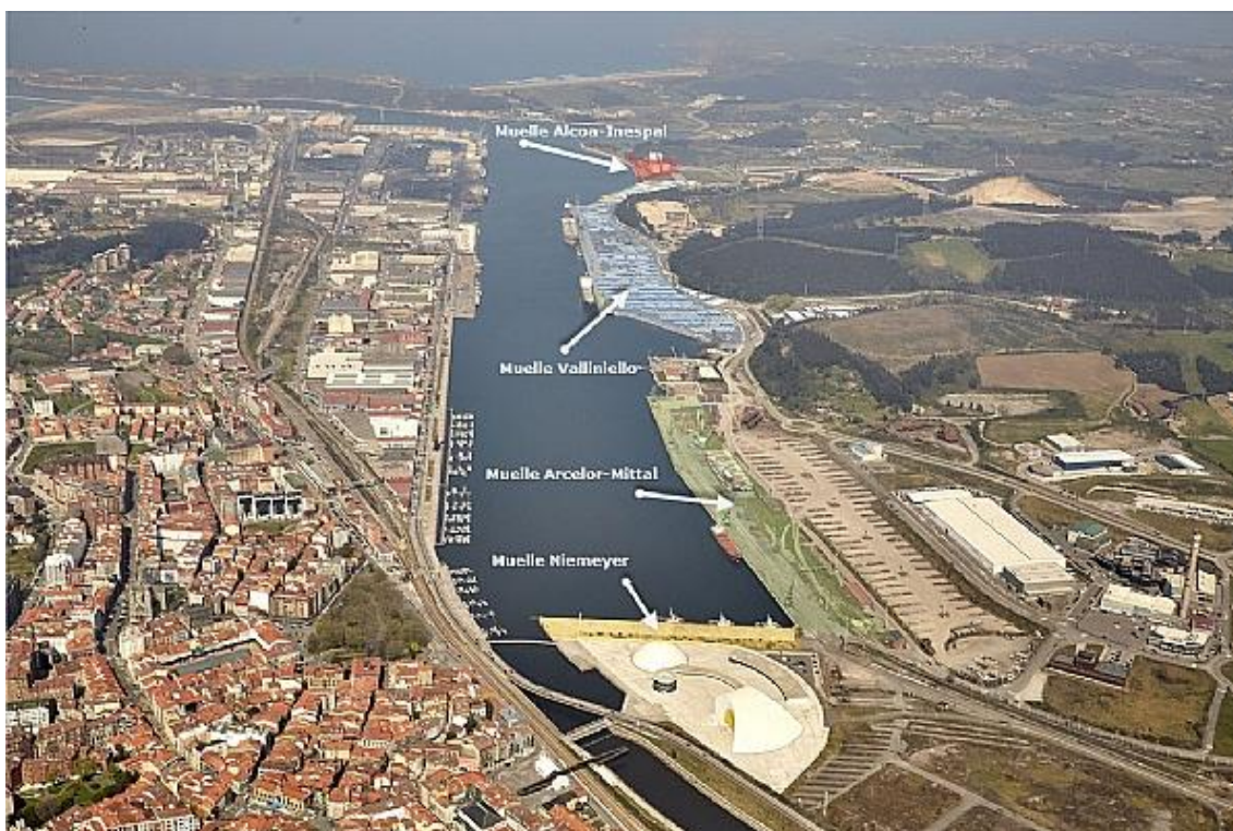
Ilustración 24. Muelles del margen derecho Puerto de Avilés. Fuente: Puerto de Avilés.
