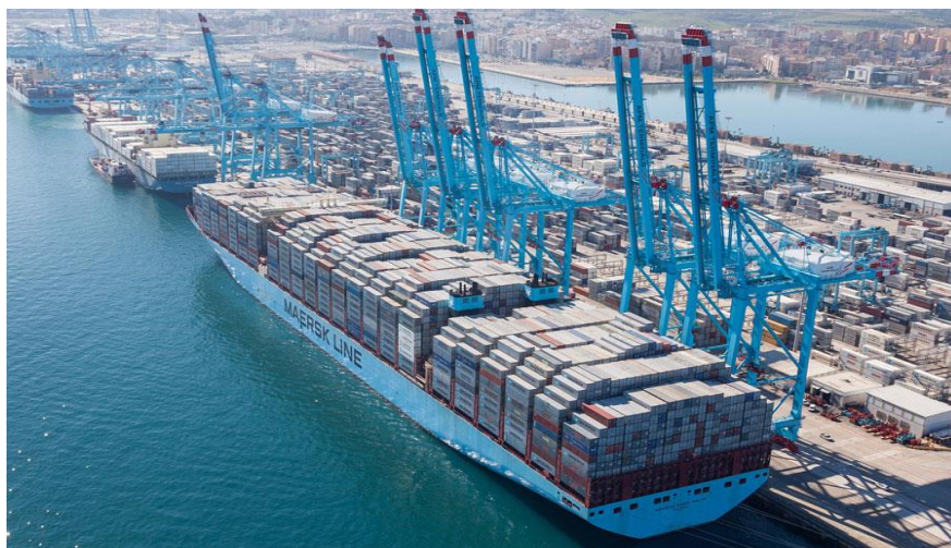
Ilustración 5. Terminal de mercancía general en contenedores del puerto de Algeciras. Fuente: Puerto de Algeciras.
