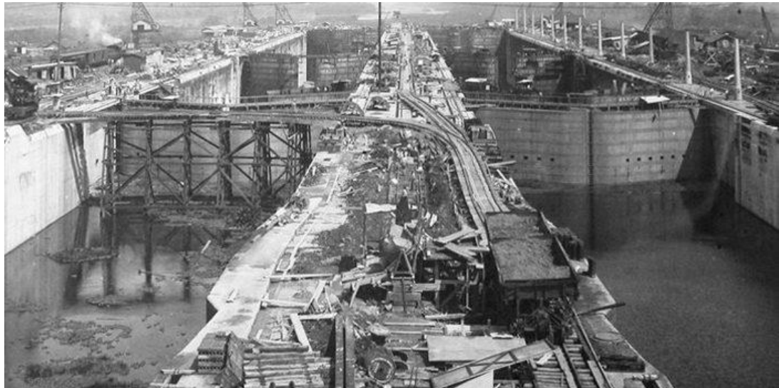
Figura 2-4 Construcción del canal. (Fuente: Panamá La Vieja, 2014).
