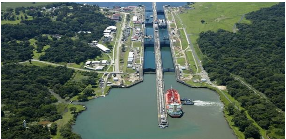
Figura 2-7 Vista aérea del canal. (Fuente: Internet/Google/Medios, mayo 2021).
