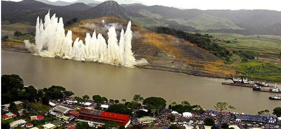
Figura 3-6 Momento de la detonación de explosivos que da inicio a las obras del canal. (Fuente: El Nuevo Diario, septiembre 2007).
