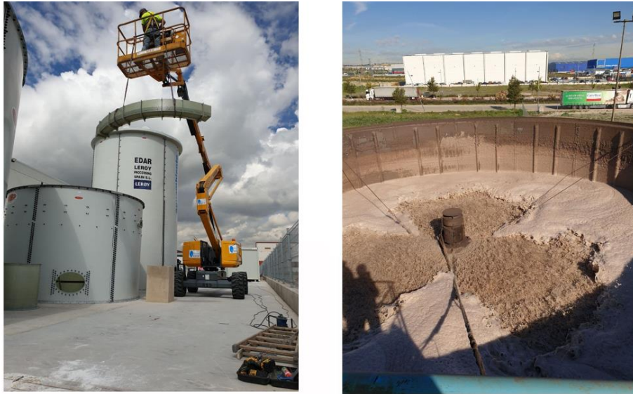
Figura 3.3. Instalación y uso del W-Tank (Fuente: Elaboración Propia)
