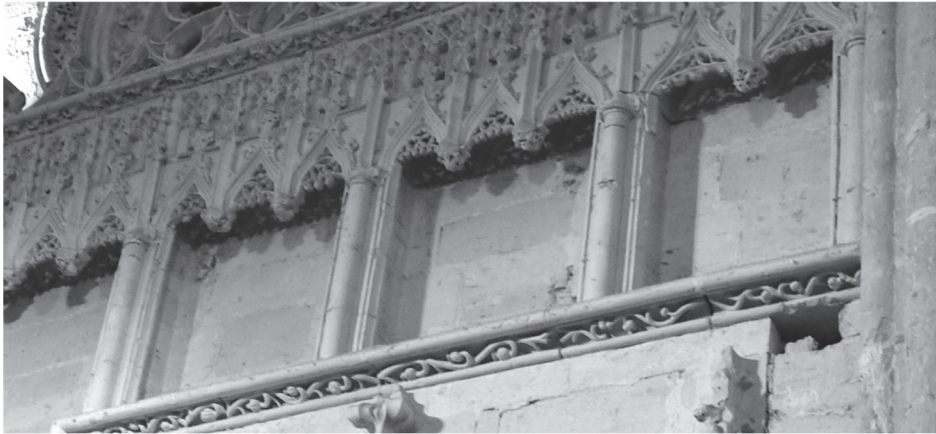
Figura 2. Muro de cerramiento del coro de la catedral de Palencia en su ubicación original
