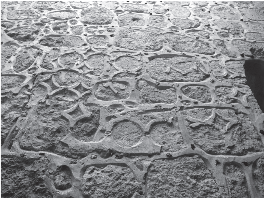
Figura 2. Superposición de acabados en el Alcázar de Segovia
