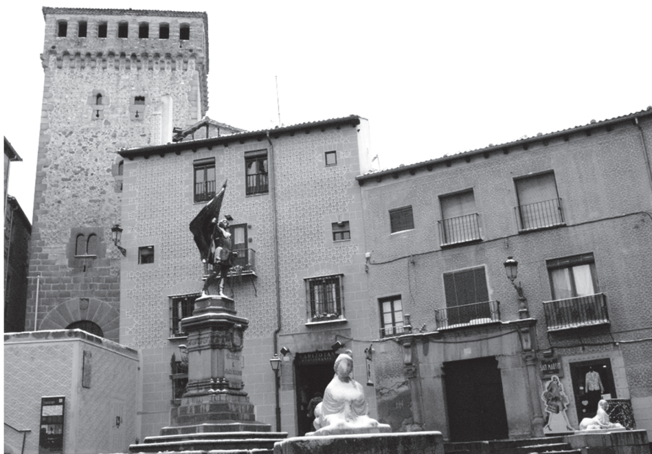
Figura 1. Sector de la Plaza de San Martín en Segovia con edificios esgrafiados
