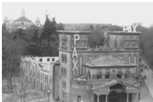
Fig. 92 Teatro Pradera. Derribo. 1968. Foto circulando en la web.
