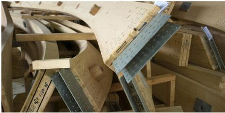
Figura 67. Detalle de unión de las lamas.
