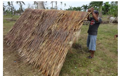
Figura 106. Cobertura de la cubierta con palmas de Nypa.
