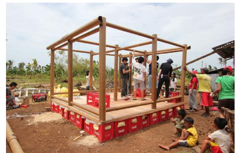
Figura 105. Estructura de tubos de papel y cimentación con cajas de cerveza con sacos de arena.
