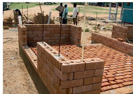
Figura 57. Sistema de colocación de los muros de CEB de las viviendas en Kirinda, Sri Lanka.
