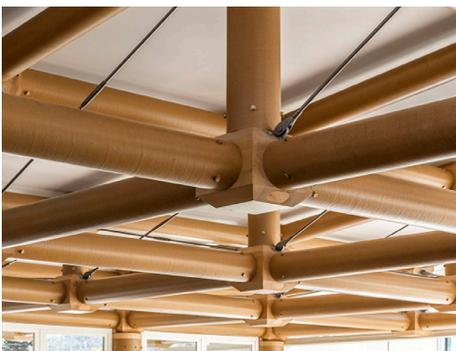
Figura 125. Detalle de las uniones de los tubos de papel mediante piezas de madera.
