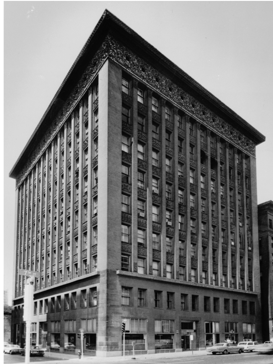
Fig. 17. Waingright Building (1891), San Luis, Misuri. Adler & Louis Sullivan. Vista general del edificio.
