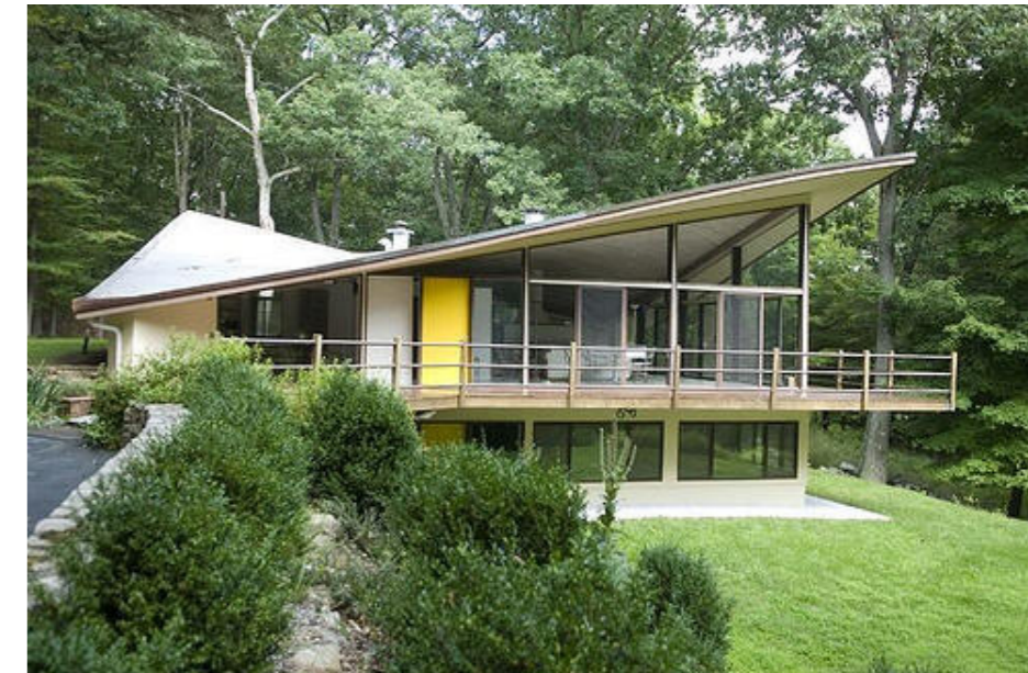
Fig. 103. Casa de de James Evans en New Canaan, 1961 Connecticut (EEUU).
