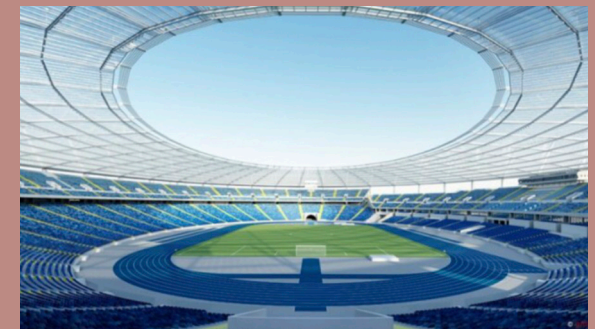
FIG.97. Fotografía interior del estadio Slaski
