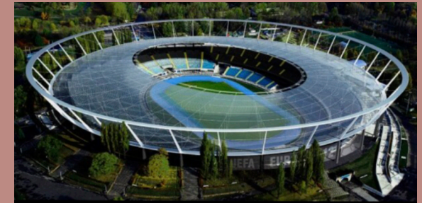
FIG.96. Fotografía exterior del estadio Slaski
