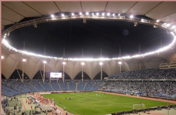
FIG.78. Fotografía interior del estadio Rey Fahd
