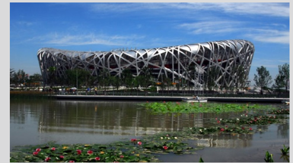
FIG.109. Fotografía exterior del estadio nacional de Beijing
