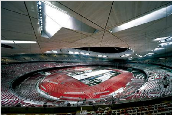
FIG.110. Fotografía interior del estadio nacional de Beijing en el que se ve el graderío
