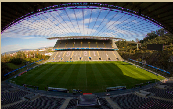
FIG.69. Fotografía interior del estadio municipal de Braga
