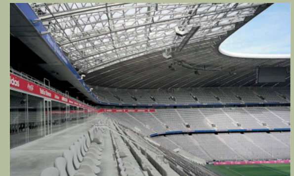
FIG.50. Fotografía interior del estadio Allianz Arena
