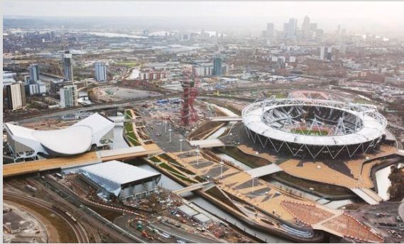
FIG.07. Fotografía de la zona olímpica de Londres 2012
