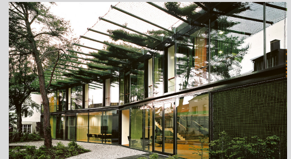
FIG.14. Fotografía del Pabellón de Ricola
