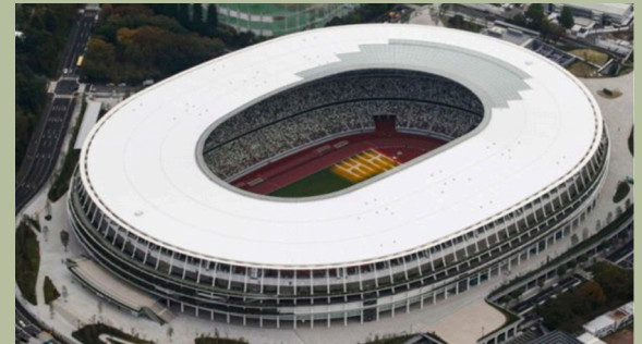
FIG.67. Fotografía exterior del nuevo estadio de Burdeos
