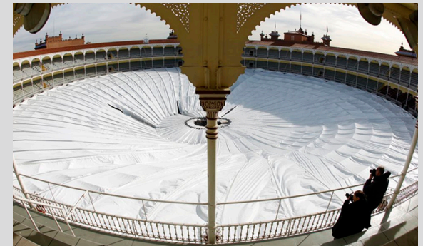
FIG.141. Fotografía exterior de la Plaza de las Ventas
