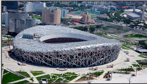
FIG.03. Fotografía aérea del estadio Nacional de Beijing
