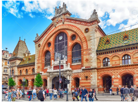
Fig. 8. Mercado Central, Budapest Fig. 9. Abajo, interior del Mercado Central, Budapest
