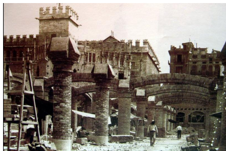
Fig. 4. Fotografía de las obras de Mercado Central
