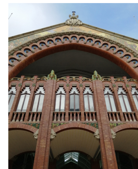
Fig. 6. Fachada de la calle Jorge Juan
