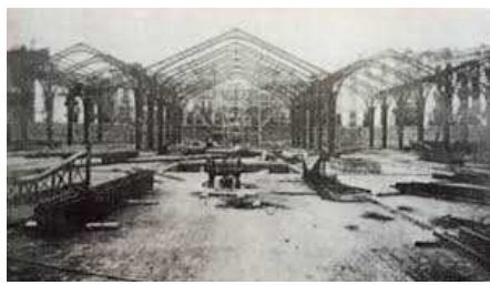
Fig. 3. Fotografía de las obras de Mercado Central
