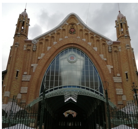
Fig. 12. Fachada de la calle Salvatierra
