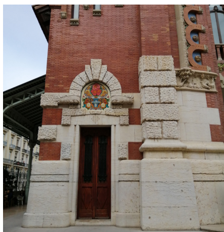
Fig. 11. Entrada a la escalera que sube hasta la pasarela
