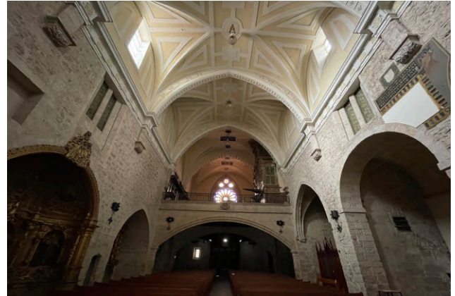
Fig. 41: Vista de la cubierta hacia la zona del coro. Fuente: Elaboración propia.
