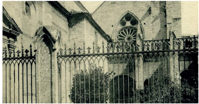
Fig. 22: Vista de la nueva tapia. Fuente: Óscar Burón.
