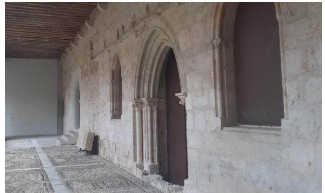
Fig. 52: Accesos desde claustro a antigua sacristía y Capilla de los Sarmiento. Fuente: Elaboración propia.
