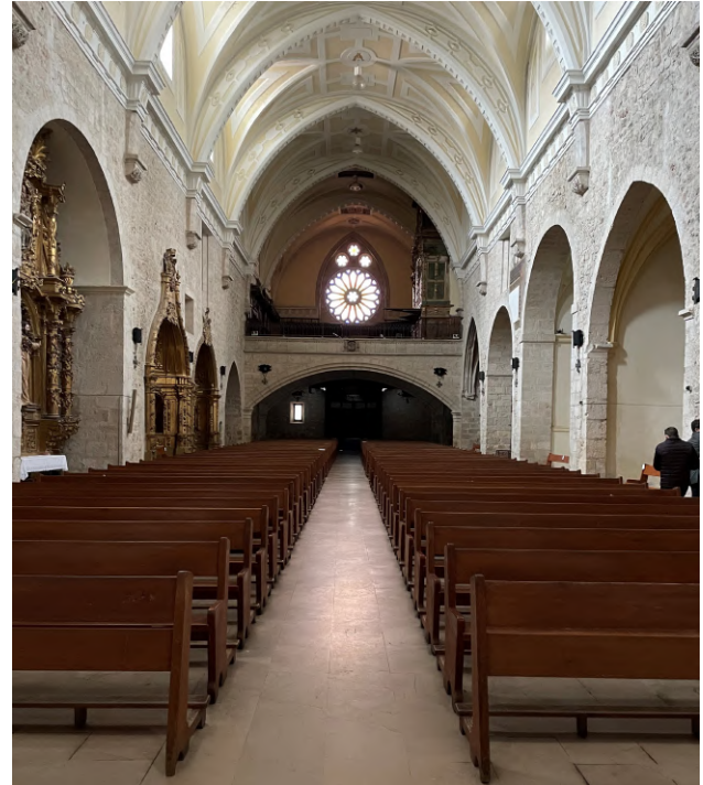
Fig. 14. Vista interior hacia el coro. Se aprecia la diferencia de materialidad entre las paredes de la nave y la nueva cubierta. Fuente: Elaboración propia.
