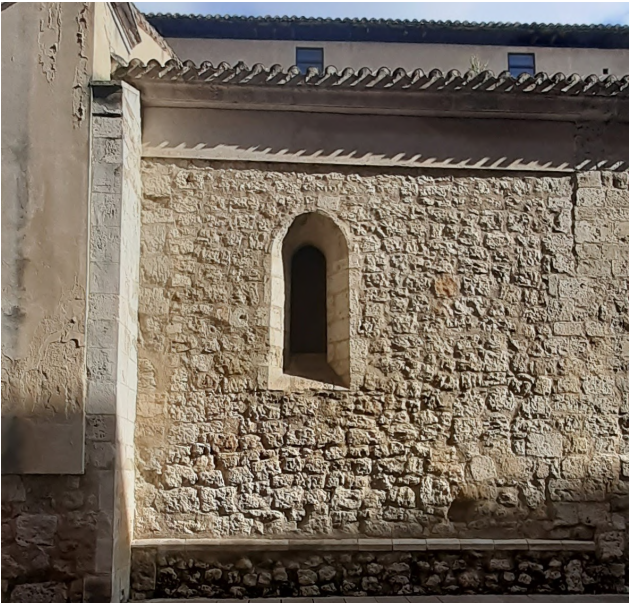
Fig. 13. Vista exterior del lado del evangelio, se aprecia la altura mayor de las ventanas posteriores. Fuente: elaboración propia.
