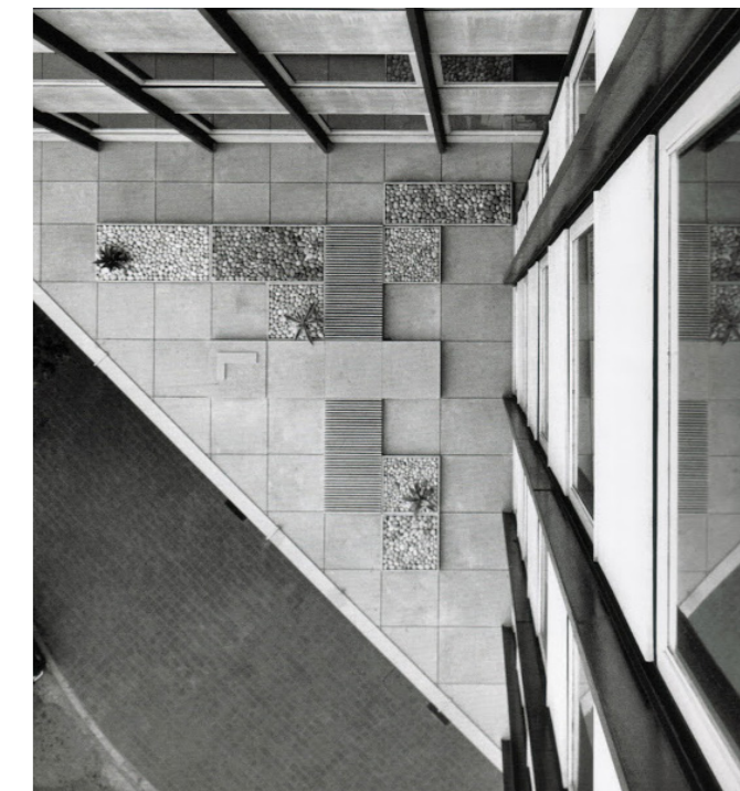
75. Edificio de oficinas y tienda showroom de Loewe en Barcelona
