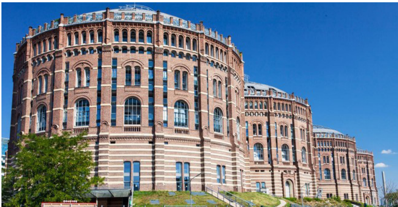
Figura 91. Vista exterior de los cuatro antiguos depósitos de gas de Viena.
