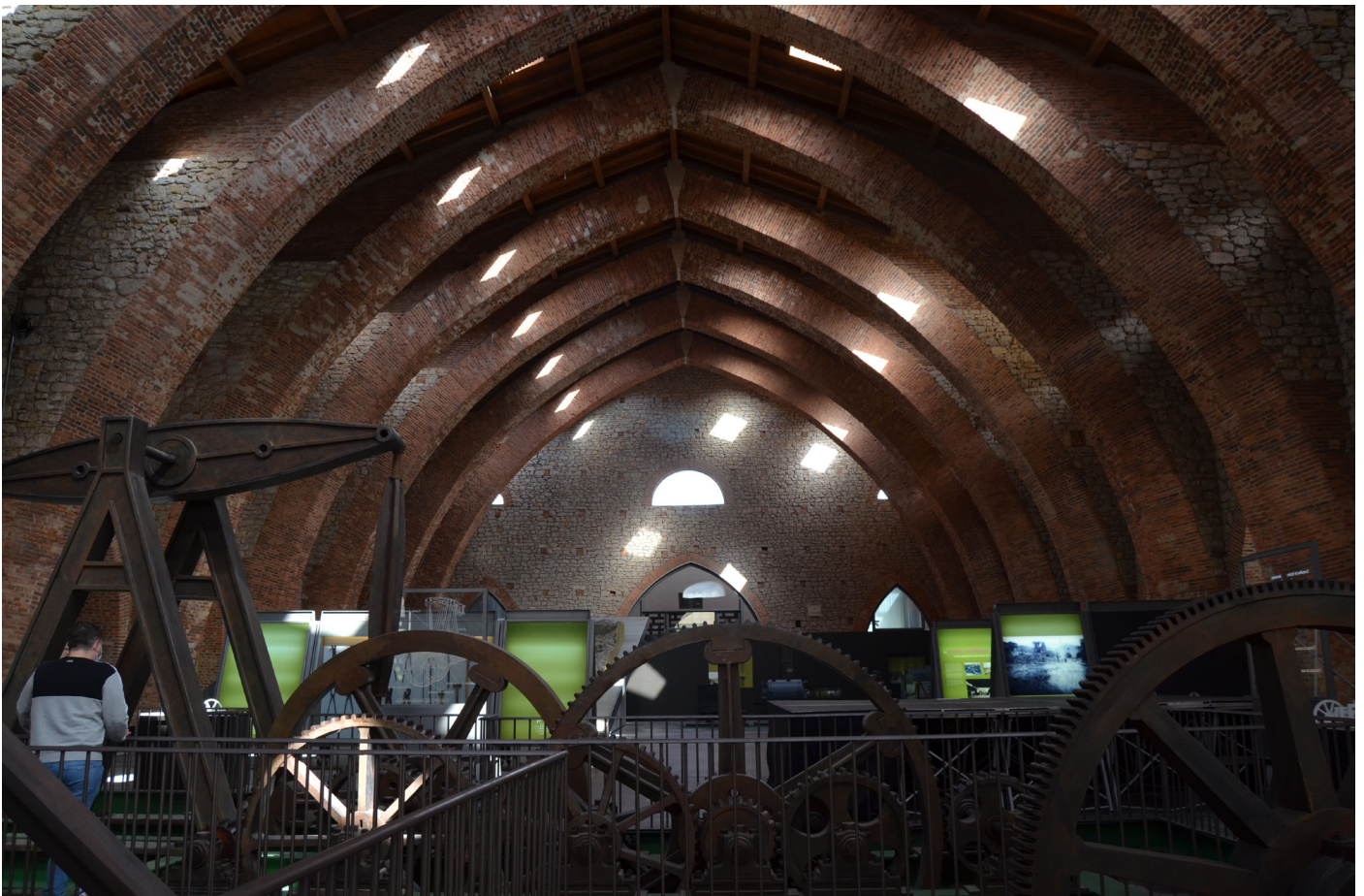
Figura 71. Interior de la nave, convertida en museo, con la maquinaria industrial y paneles informativos.
