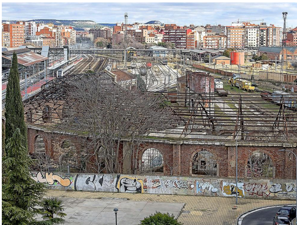
Figura 21. Depósito de locomotoras de la Estación del Norte.
