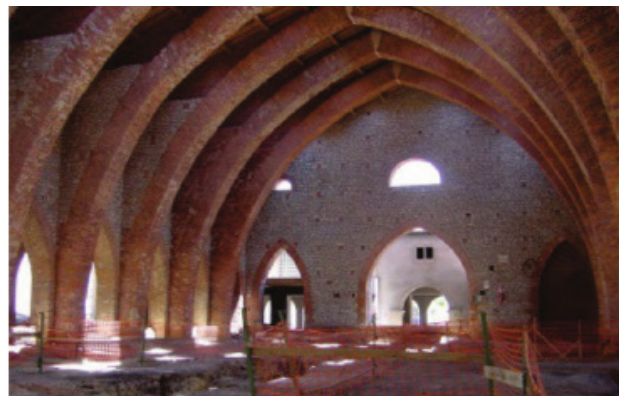
Figura 66. Interior de la nave en 2001.
