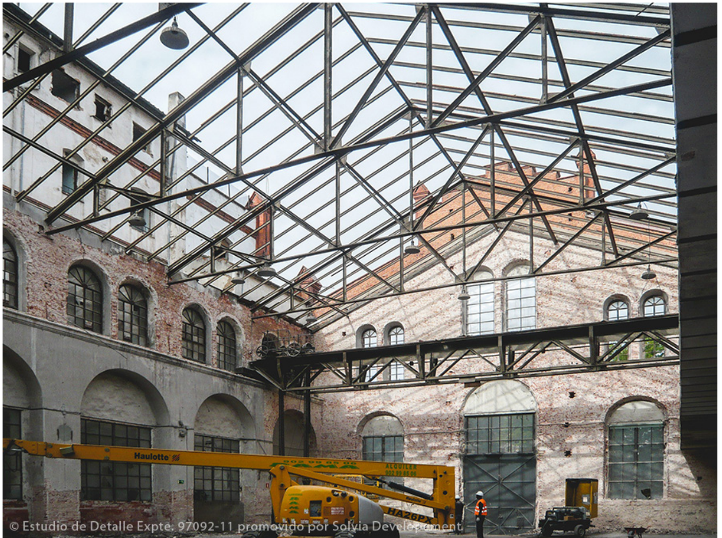
Figura 35. Estructura de cerchas metálicas de la nave central.
