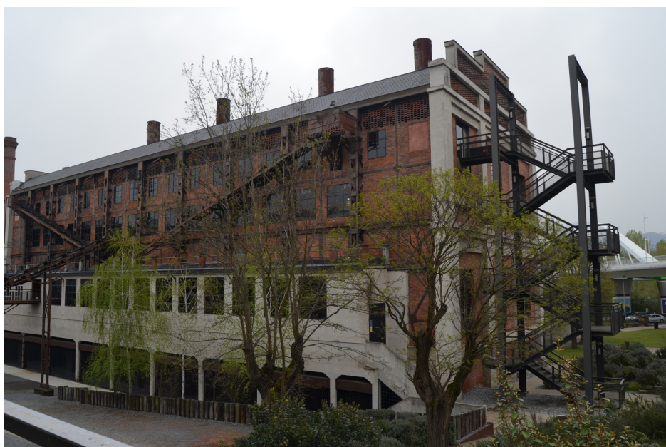
Figura 53. Nave de calderas.
