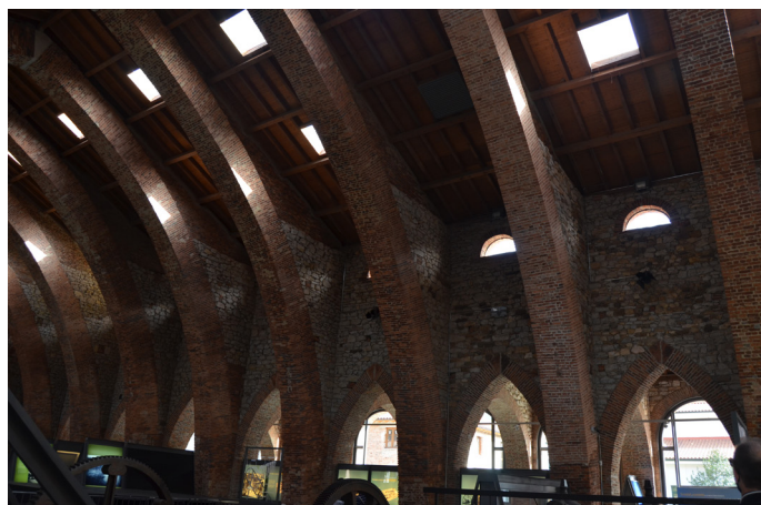
Figura 73. Interior de la nave. Estructura de arcos diafragma.
