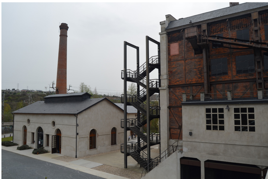
Figura 52. Exterior del Museo Nacional de la Energía. Central primitiva y nave de calderas. Al fondo, la chimenea.
