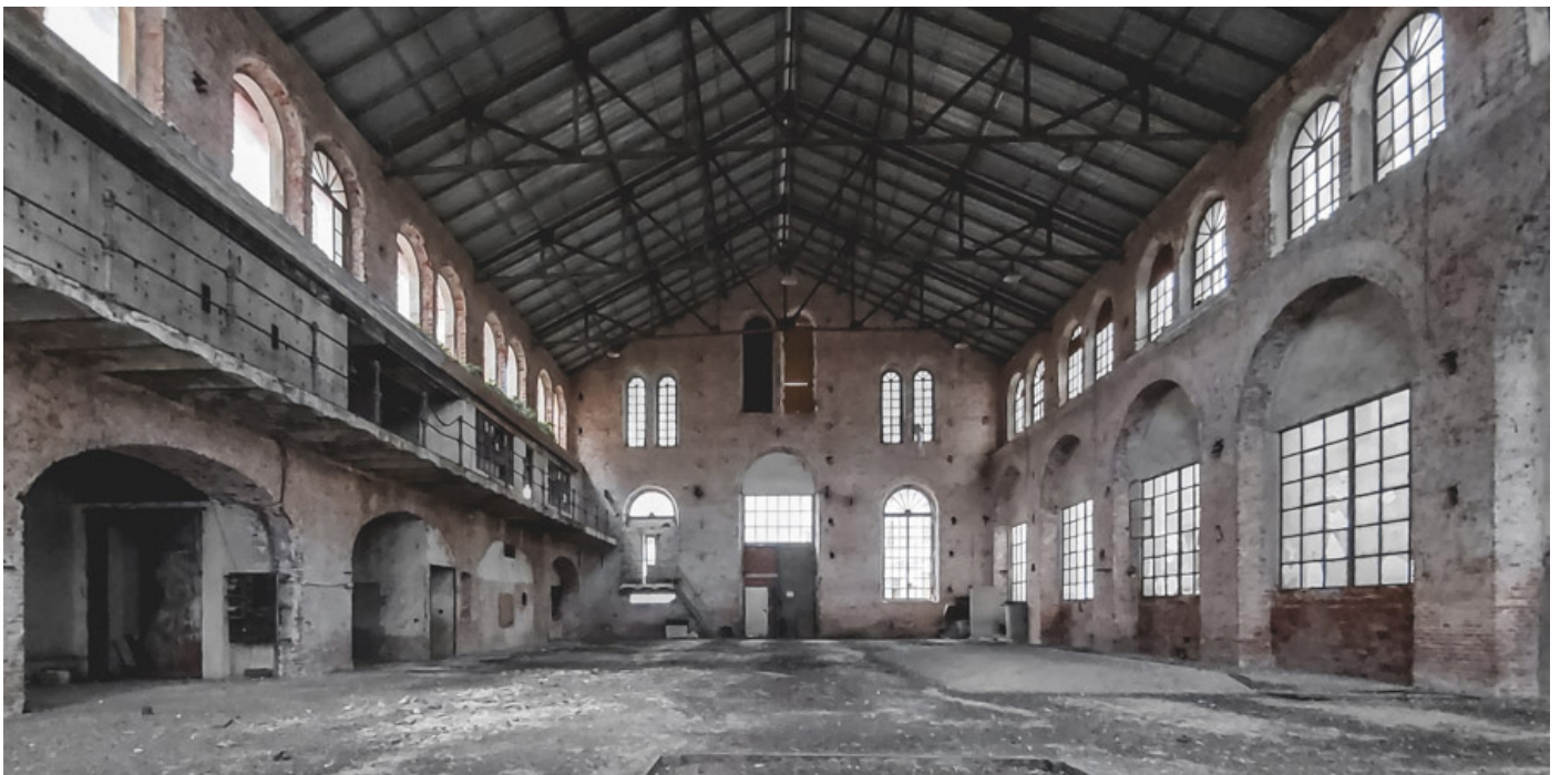
Figura 31. Interior de la nave central de la Electra Popular Vallisoletana.
