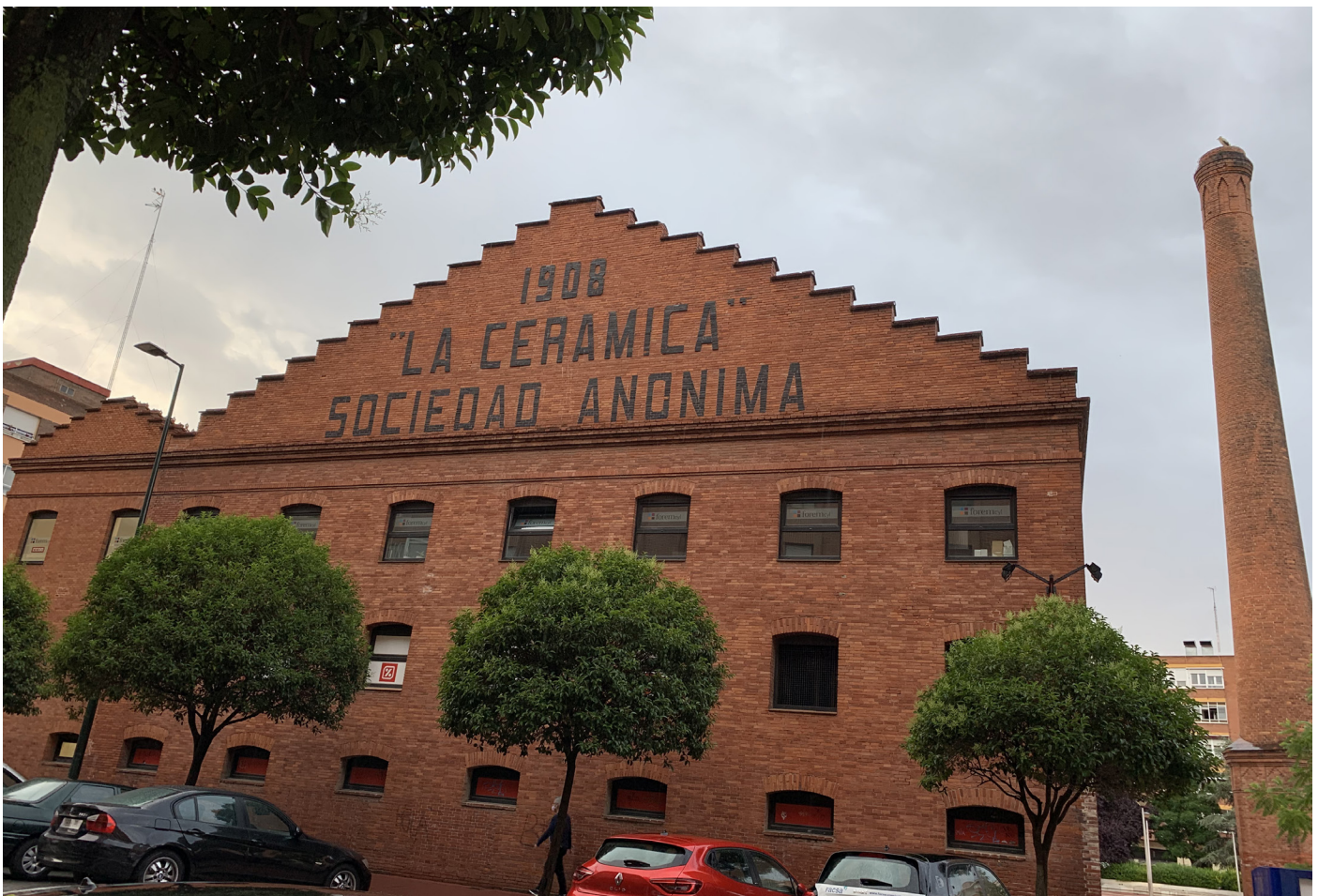
Figura 88. Exterior de la fábrica, con la chimenea de ladrillo.
