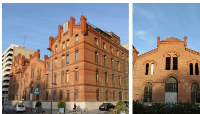
Sala de máquinas de la central de la Electra Popular en 1911 e imagen actual de la fachada del edificio. / ARCHIVO MUNICIPAL Y HENAR SASTRE
