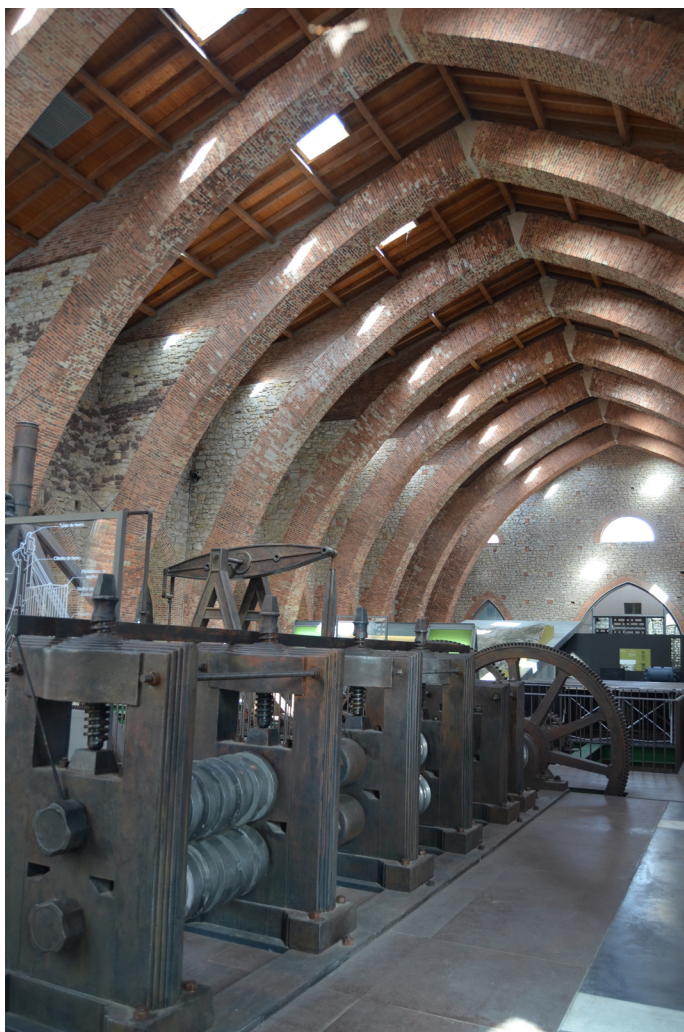
Figura 72. Interior de la nave. Estructura de arcos diafragma.
