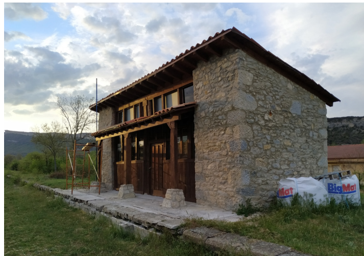
i19/ Marquesina de la estación de Brizuela, 2021
