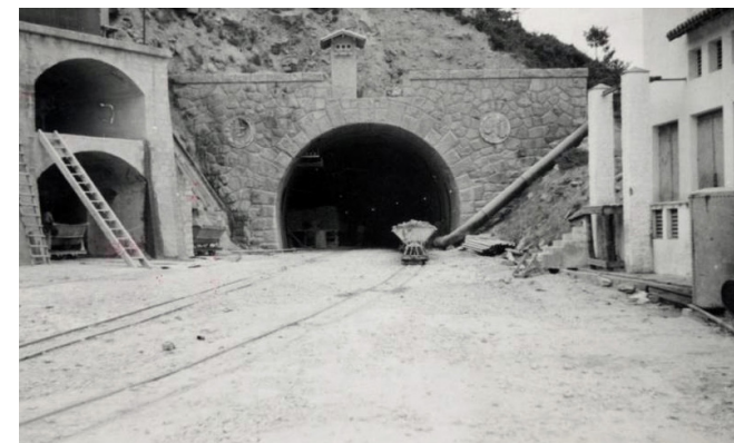
i48/ Boca sur del Túnel de la Engaña durante su construcción
