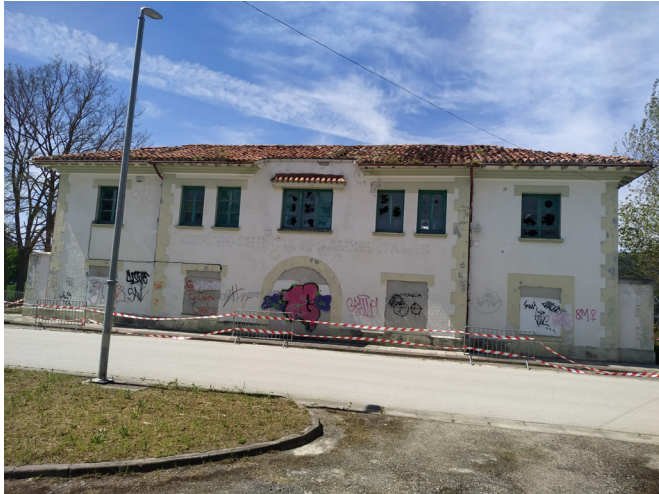
i21/ Estación de Villarcayo fachada de acceso desde la población, 2021
