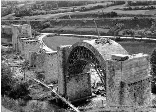
i8/ Construcción viaducto de Santelices, 1925
