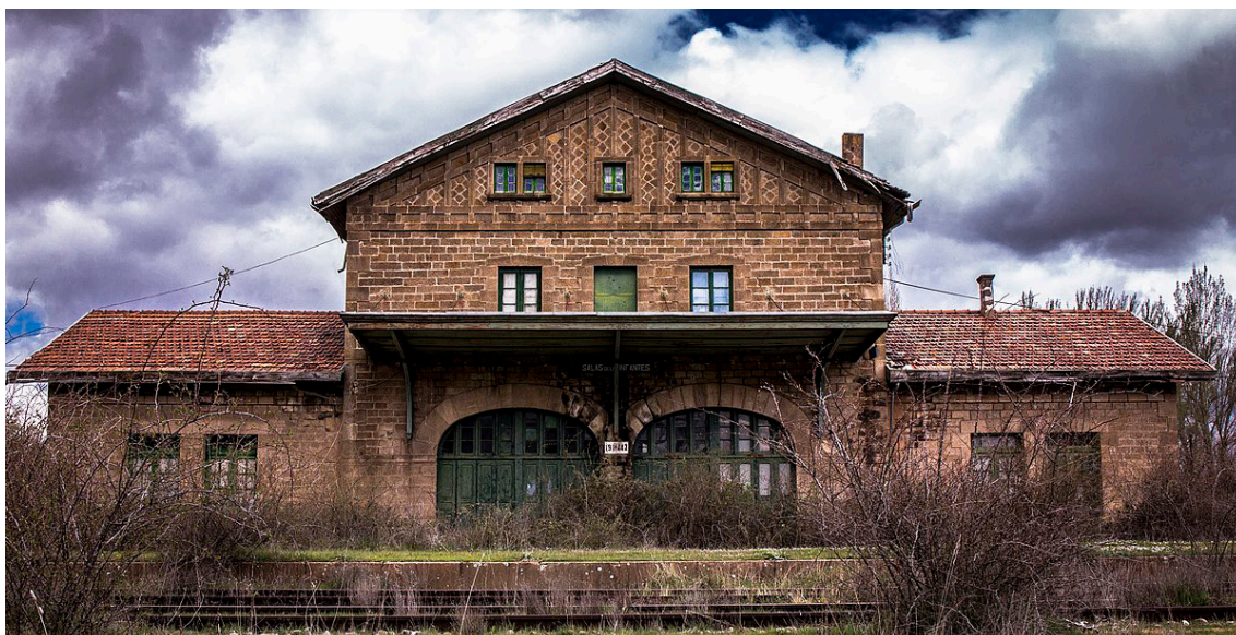
i37/ Estación de Salas de los Infantes, alzado hacia las vías, 2015
