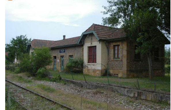
i28/ Estación de Castrillo de la Reina
