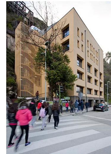
114/ Edificio de aulas después de la rehabilitación
