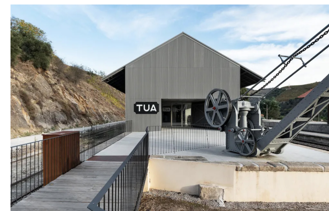
17/Hangar norte después de la rehabilitación, 2018
