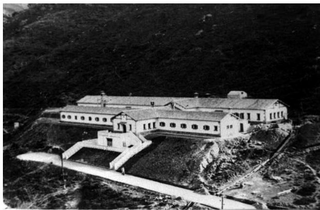
i47/ Hospedería boca sur durante la construcción del túnel
