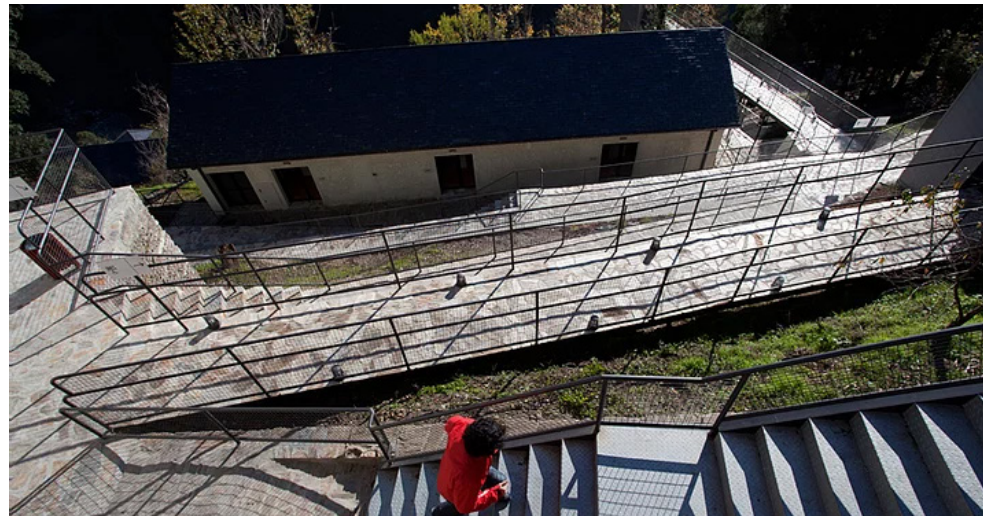
113/ Poblado Os Peares después de la rehabilitación, nuevas rampas para generar recorridos accesibles
