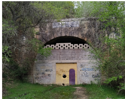
i12/ boca sur del túnel en el poblado de La Engaña, 2021
