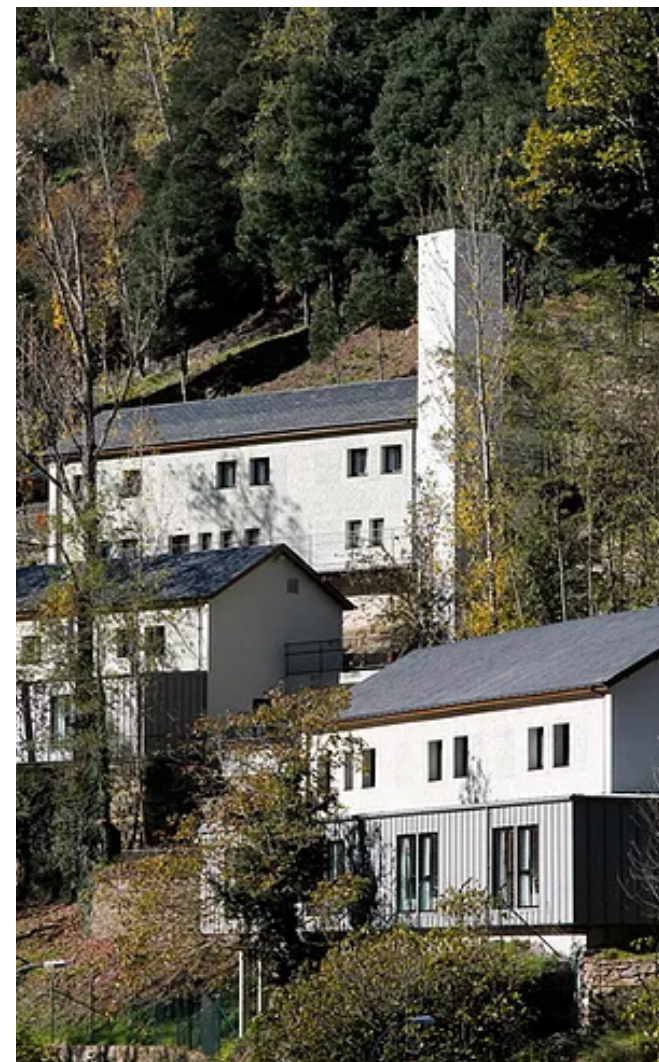
111/ Viviendas y ascensor después de la rehabilitación, Os Peares
