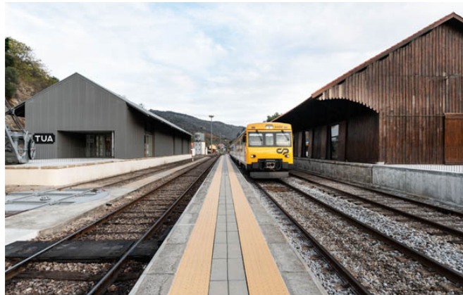
15/Imagen hangar estación Vale do Tua después de la rehabilitación, 2018
