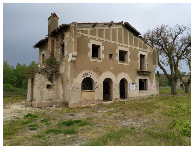
i26/ Estación de Poza de la Sal, 2021
