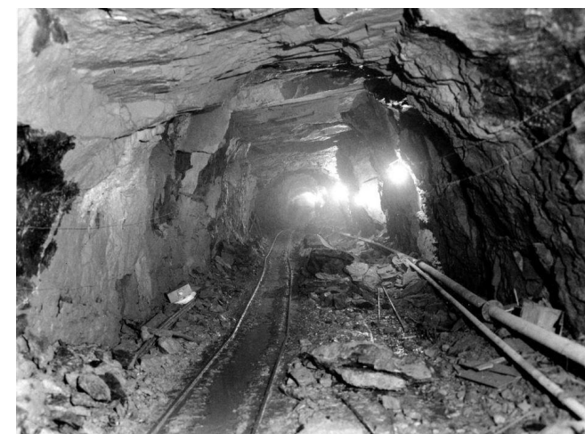
i41/Interior del túnel de La Engaña durante las obras de perforación
