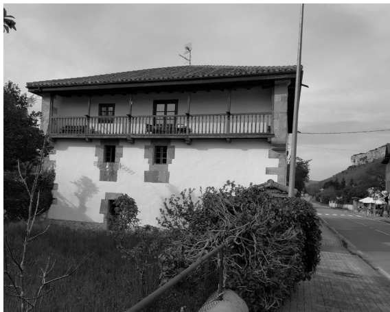
i7/ Vivienda en Pedrosa de Valdeporres
