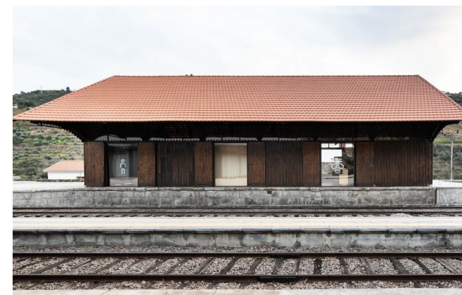
16/Imagen hangar sur después de la rehabilitación, 2018
