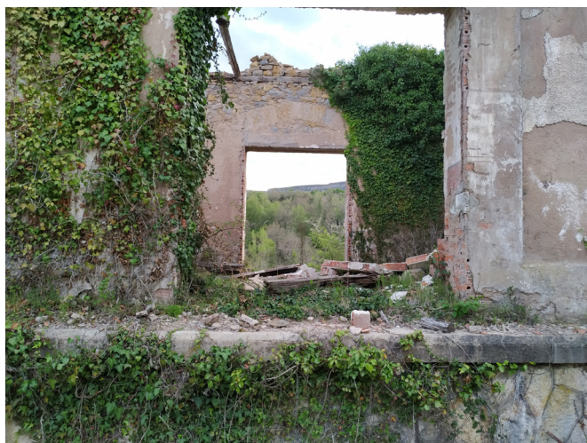
i4/ Almacén y vía verde de la estación de Ciudad-Dosante, 2021
