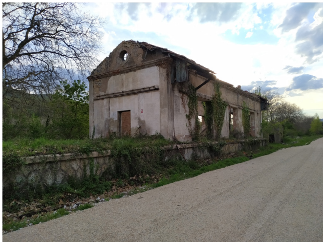
i3/ Almacén y vía verde de la estación de Ciudad-Dosante, 2021
