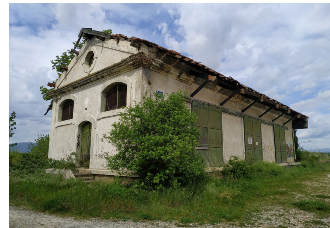
i36/ Muelle de la estación de Medina de Pomar,
