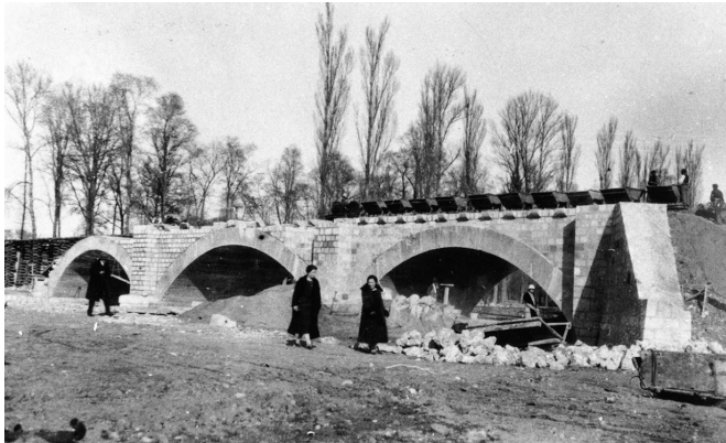
i9/ Construcción puente de los ingleses Burgos, 1925
