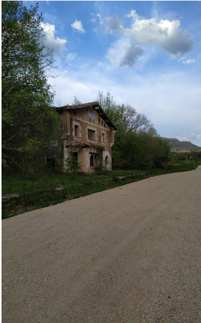
i7/ Vía verde a su paso por la estación de Ciudad-Dosante, 2021
