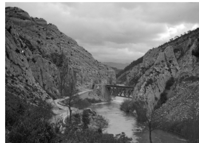
i4/ Puente del S-M sobre el río Ebro en Trespaderne, 1930
