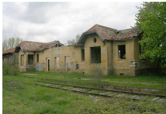
i28/ Estación de Revilla del Campo
