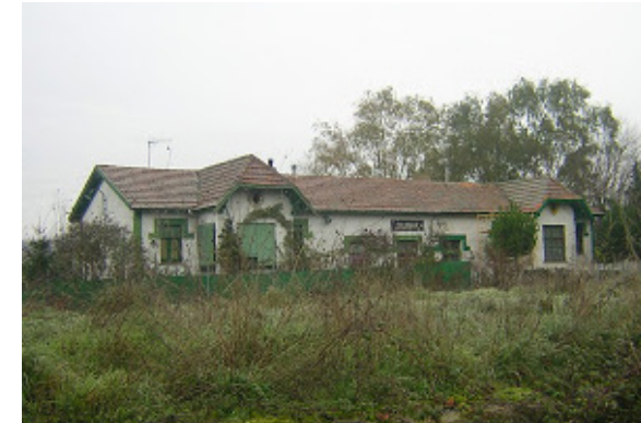
i28/ Estación de Cojóbar
