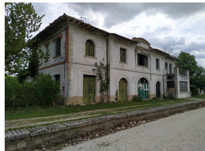
i23/ Estación de Medina de Pomar fachada hacia las vías, 2021
