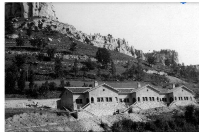
i45/ Viviendas de los ingenieros en la boca sur del túnel durante su construcción
