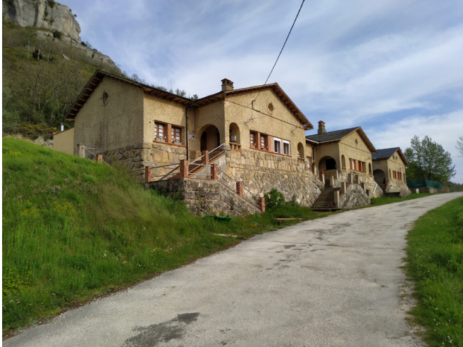
i6/ Viviendas de los ingenieros en Pedrosa de Valdeporres, 2021
