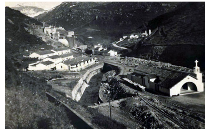
i44/ En primer plano la iglesia del poblado de La Engaña, detrás las viviendas de los trabajadores libres
