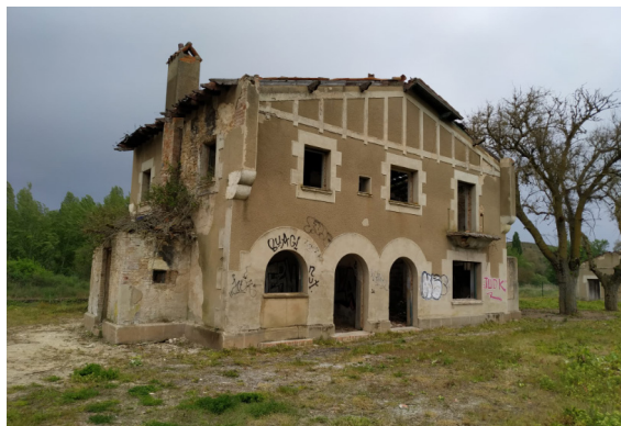
i23/ Estación de Poza de la Sal, 2021
