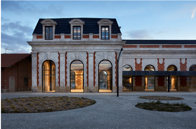
11/ Fachada hacia las vías de la antigua estación de Burgos rehabilitada, 2016
